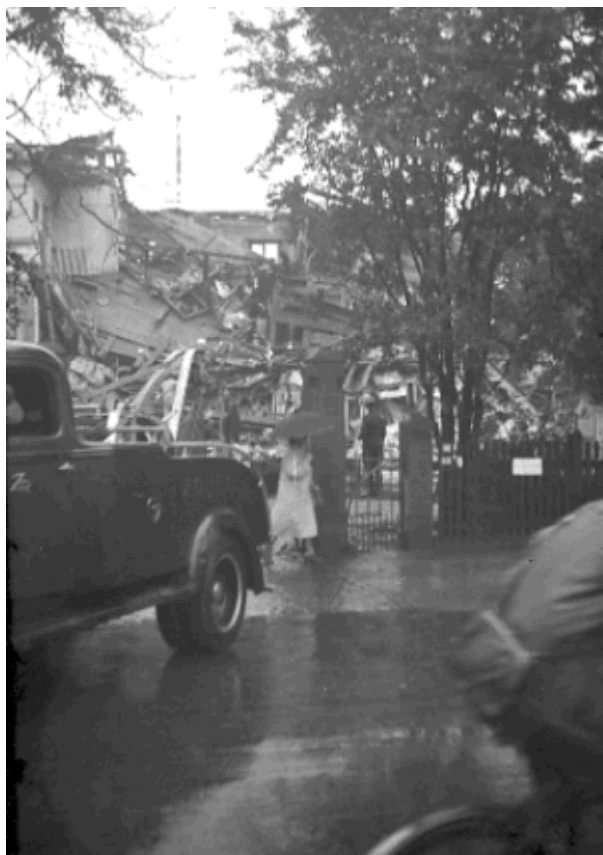
Billedet er formentlig fra sprængningen af Gunnar Bomhoffs villa.
