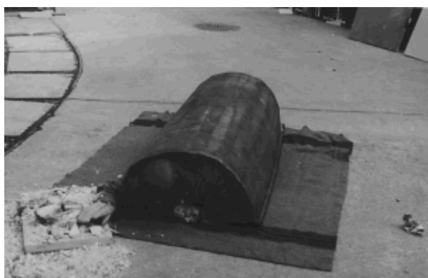
Person-beskyttelsesdæksel anvendt under arbejdet på Thilesvej.
