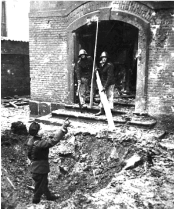
Stig Frisholt og to løsarbejdere med Zone-hjelme ved bombekrater foran Kristianskirken.
