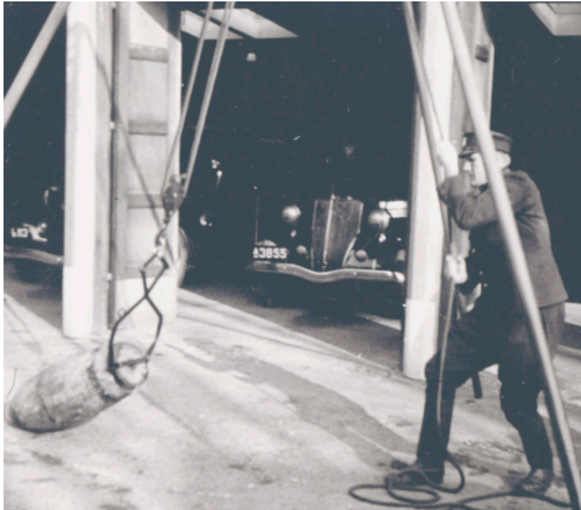
Kjeld Lyngby Sørensen afprøver, om en bombe kan løftes med den særlige gribetang.
