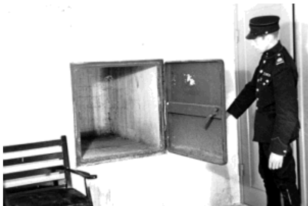
Forsyningskakt i Gasbeskyttelseskælderen på Platanvej.
