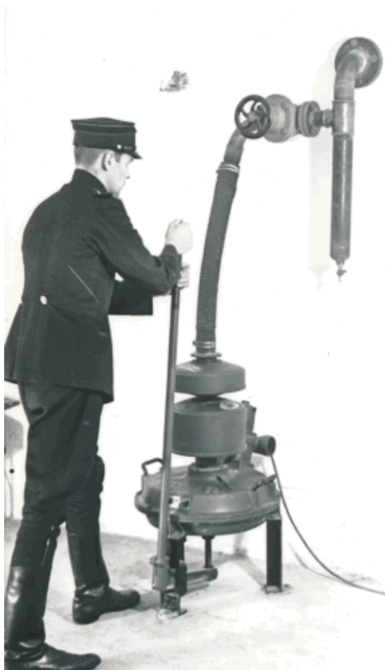
Friskluftsanlæg i beskyttelseskælderen på Platanvej.
