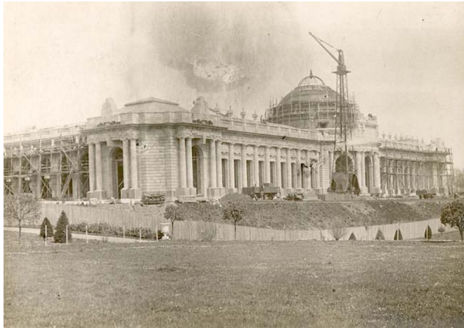
Construction du musée © KMMA / MRAC AP.0.0.41715
