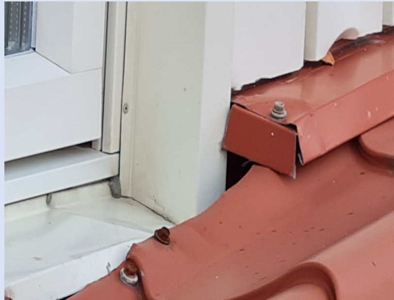
Tak med plåtdetaljer som inte tätar mot fasad och fönster.
