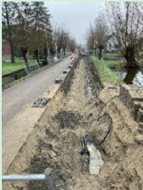
Leidingwerk aan 's Gravenweg
