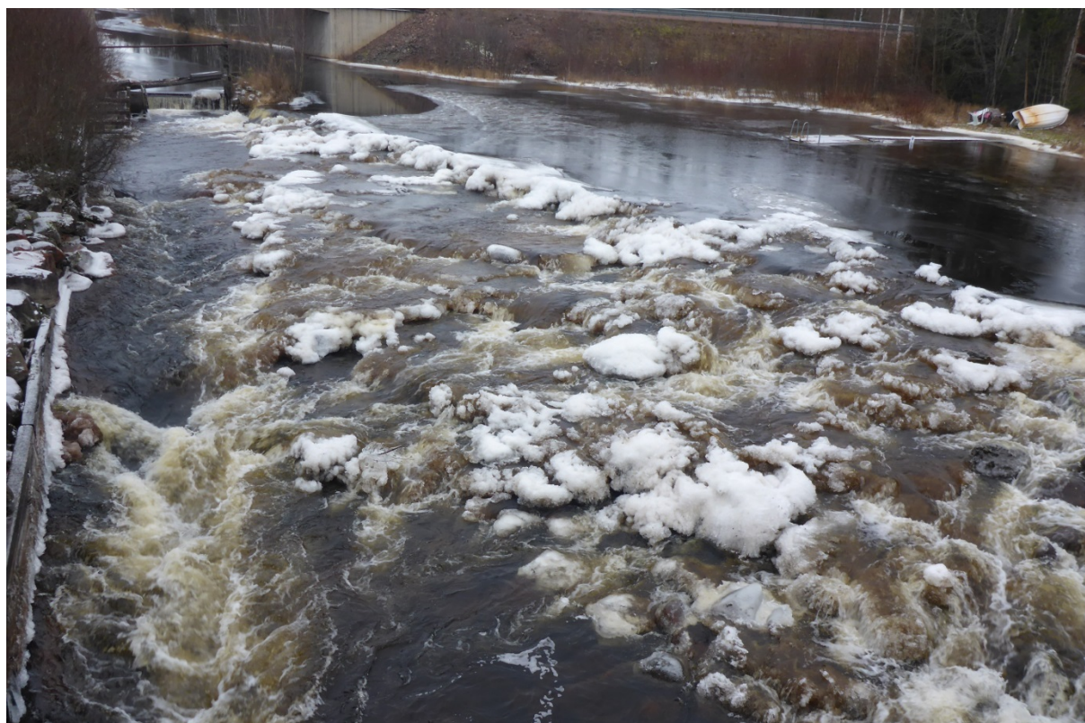
Figur 8. Vy från gamla vägbron mot överfallsdammen – här vid en relativt normal vattenföring om än ett det högre slaget.
