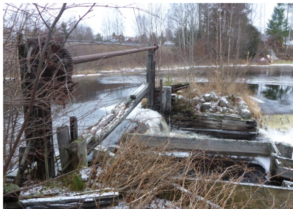
Figur 3. Dammens utskov ska avlägsnas med dess järn- och trädetaljer.
