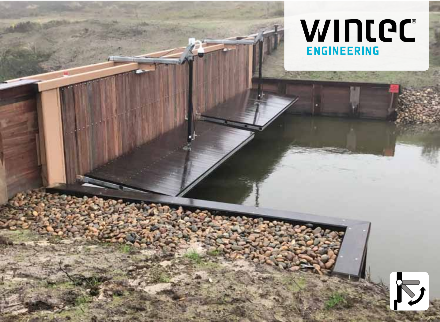
Klapsluse ved Henne Mølleå, afløb Filsø.
