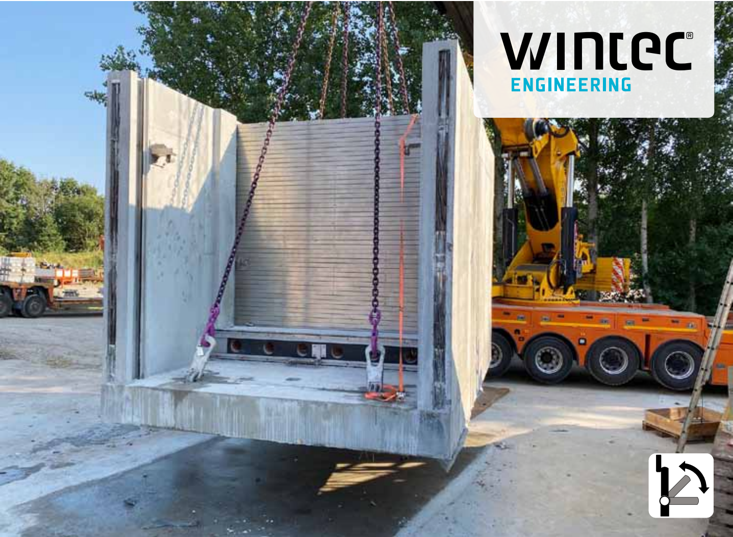
AquaBlok™ præfabrikeret kipsluse med skylesystem designet til Ringkøbing, Skelbækken.
