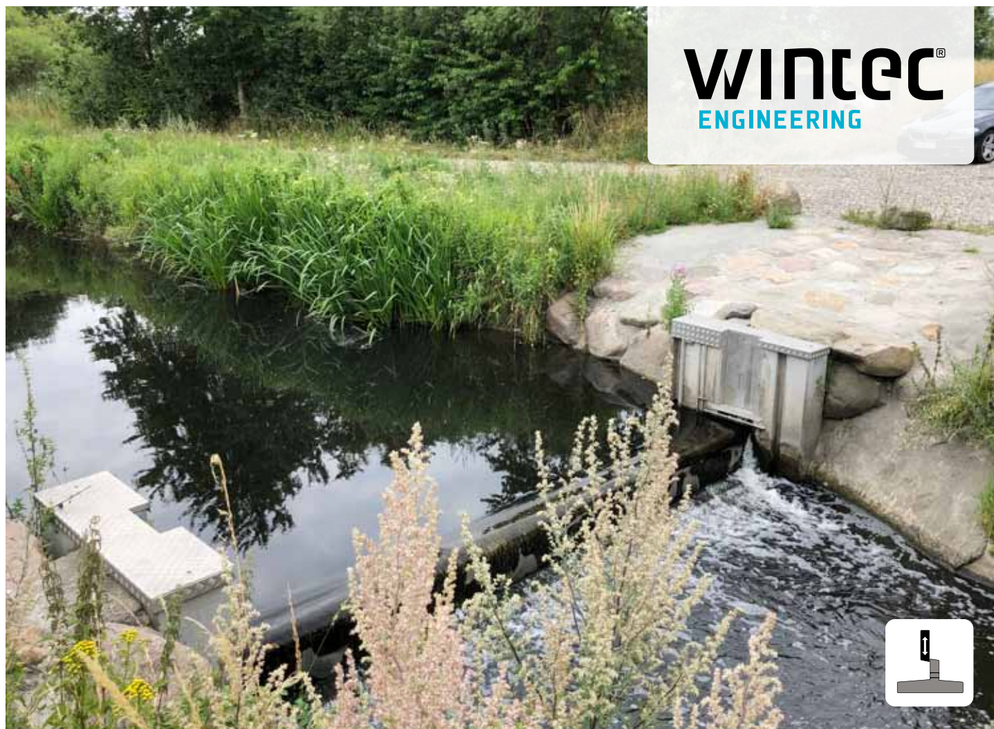
AquaBlok™ præfabrikeret sluse 6m, designet til SK Forsyning, Slagelse. Anlægget er monteret på 48 timer til fuld drift.
