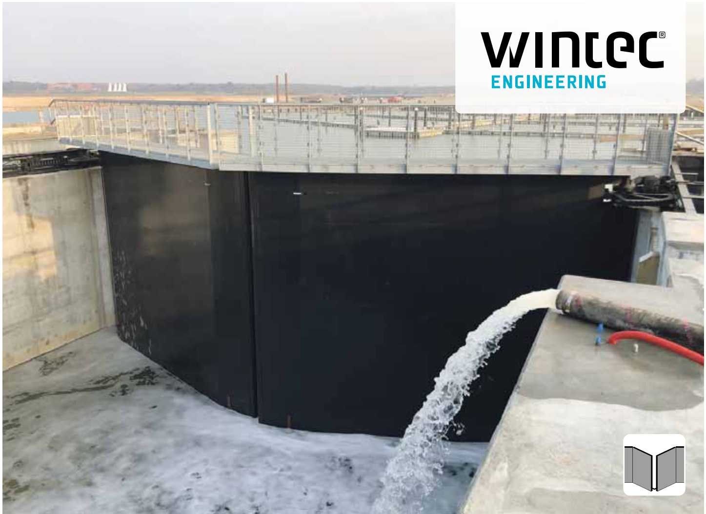
Esbjerg Strand, sluseport total bredde 17m, højde 8,5m. Hver port vejer ca. 40 Ton. Total stål leveret inkl. stoplogs 260 Ton.
