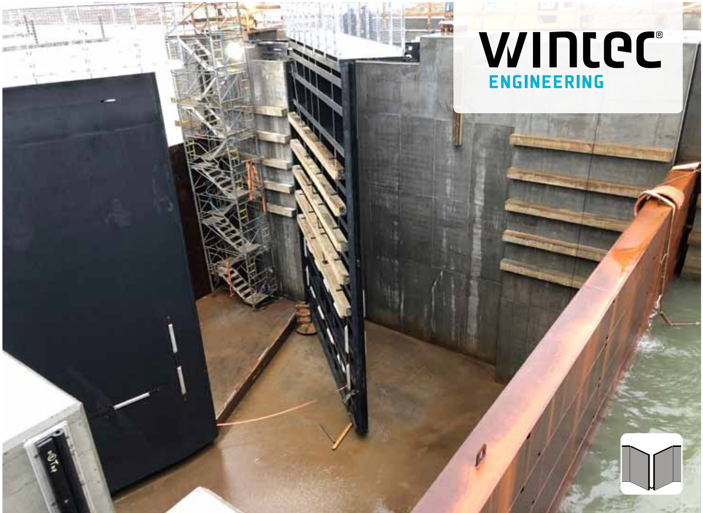
Esbjerg Strand, Sluseporte og stoplogs som holder vandet tilbage mod forhavnen.
