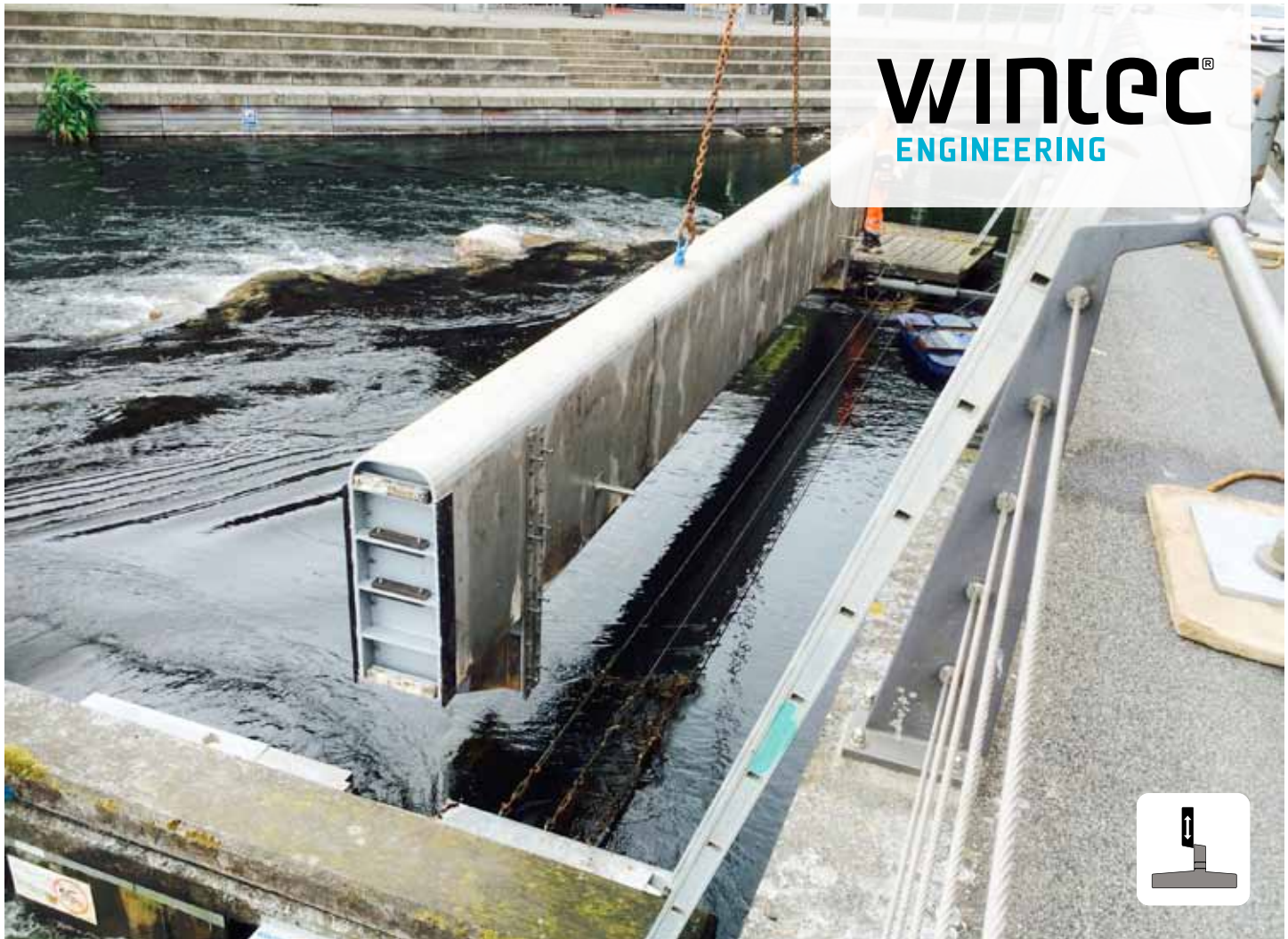
Faunapassagen Silkeborg Papirfabrik, Sluse 1. Genmontage af sluse efter fatigue test. Klar til de næste 15 års drift.
