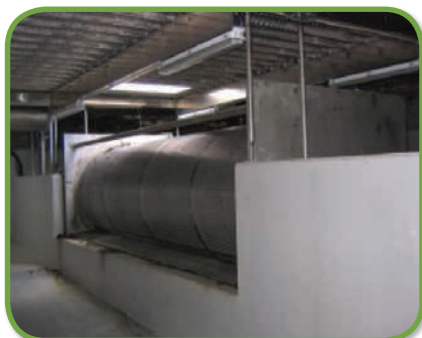
Tromlesi med endeplader (indløb-udløb-overløb)
