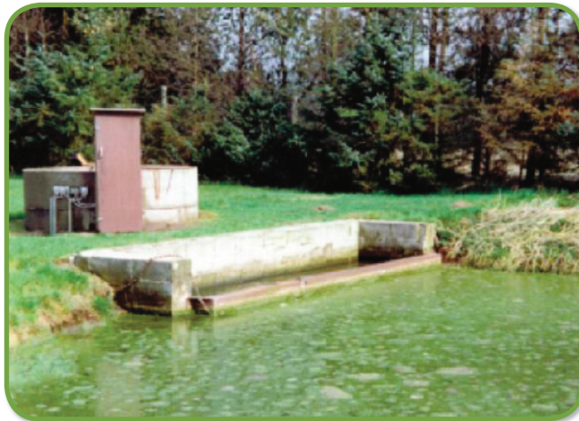
Bundfældningsbassin og overfaldskant bliver erstatte af tromlefilter (se billede til højre)
