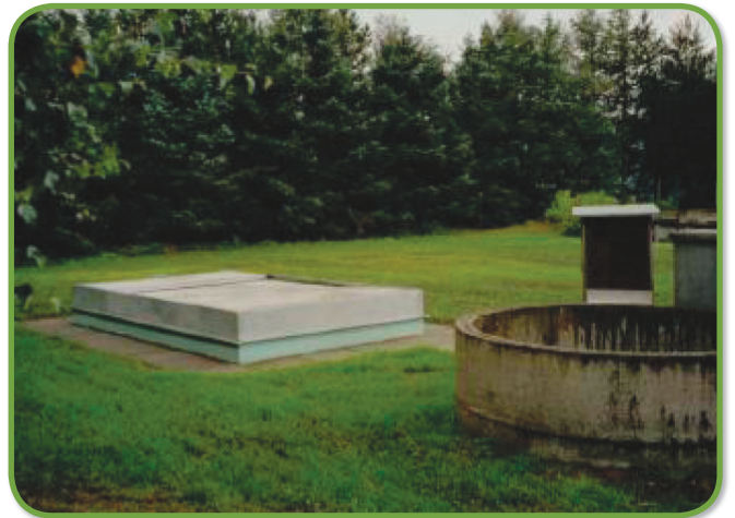
Nedgravet tromlefilter, som har erstatte bundfældningsbassin og overfaldskant
