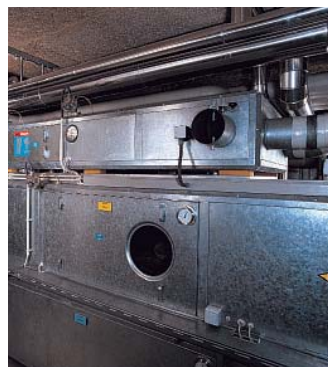
Elastische Lagerung verhindert Übertragung der Vibrationen und entdröhnt die Verkleidungsbleche.
