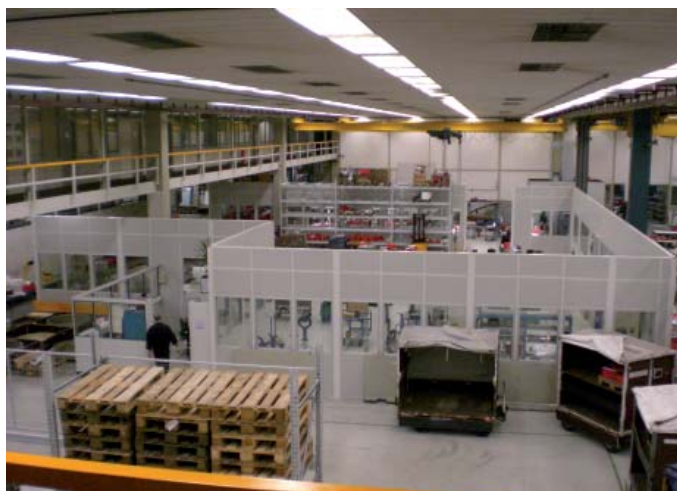
Lärmschutzwände in Modulbauweise.
