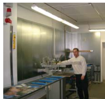
Produktionsbereich mit dicht an den Lärmquellen abgehängten Absorbieren zur Optimierung der schallabsorbierenden Wirkung (Montage mit Radius).
