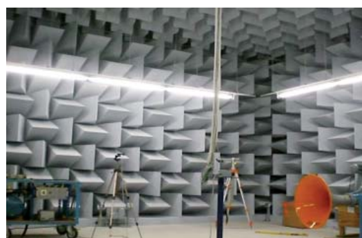
Reflexionsarmer Raum mit illsonic® Keilen ausgekleidet. Die Keile sind demontierbar an Drahtspitzen aufgesetzt. Das Material ist schwerentflammbar nach DIN 4102 B1, faserfrei und hat einen hohen Lichtreflexionsgrad. Hier können nach DIN EN ISO 3745 Geräuschmessungen und Schalleistungsmessungen nach dem Hüllflächenverfahren mit einer unteren Grenzfrequenz f_u von 100 Hz (oder niedriger) durchgeführt werden.
