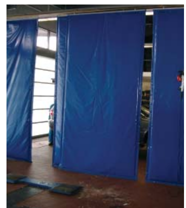
Abtrennung eines Lärmbereichs durch verschiebbare Schallschutzvorhänge, die einseitig schallabsorbierend sind.
