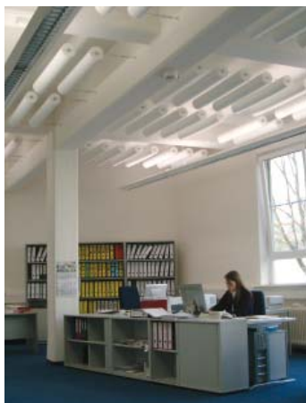
Zylindrische Absorber mit Seilaufhängung: Kombination von Akustik, Beleuchtung und Design.
