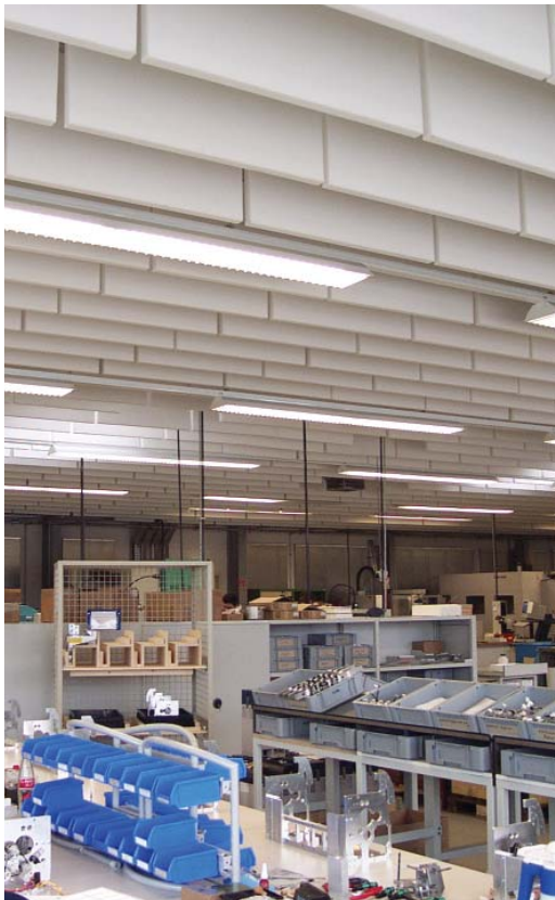
Industriehalle ausgestattet mit senkrecht abgehängten Schaumstoff-absorbieren in weiß für gute Lichtreflexion. Die Absorber sind nach DIN 4102 B1 schwerentflammbar und werden an handelsüblichen T-Schienen montiert. Kombiniert mit Wandabsorbieren im hinteren Hallenbereich.
