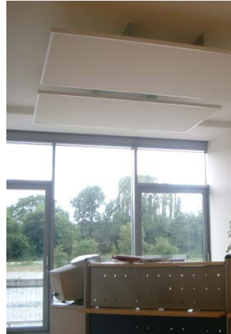
Akustik-Deckensegel zur Verbesserung der Sprachempfindlichkeit im Empfangsbereich (auch bei betonkernaktiven Decken).
