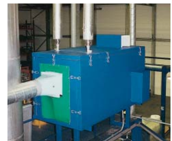
Kapselung eines Lüftungsgerätes. Durch Spannverschlüsse sind alle Teile demontierbar.
