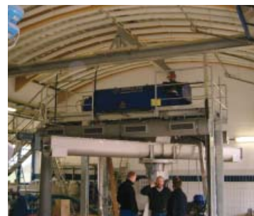
Produktionsbereich mit dicht an den Lärmquellen abgehängten Absorbieren zur Optimierung der schallabsorbierenden Wirkung (Montage mit Radius).
