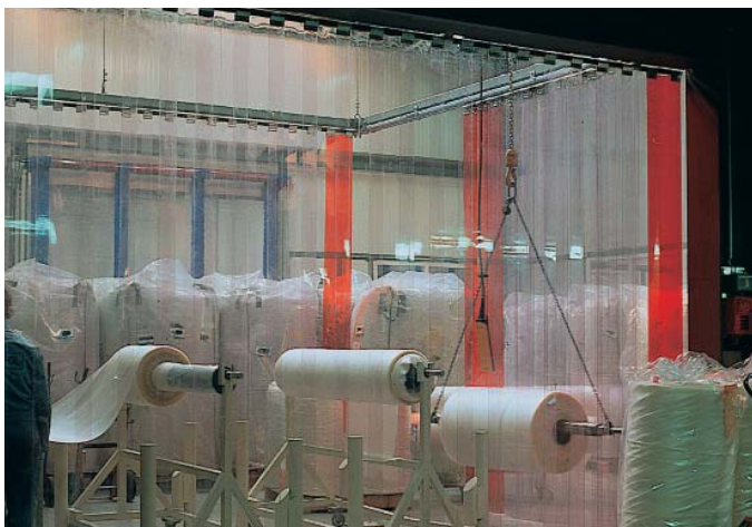
Abtrennung eines Durchgangsbereichs gegen Schall, Zugluft und Staub.
