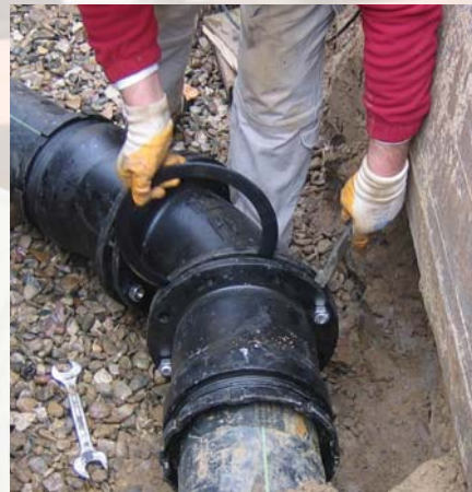
Gummipakning monteres
