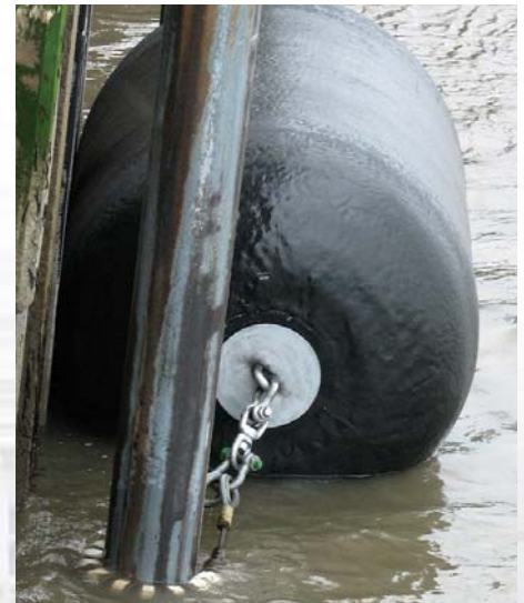
Skumfyldt PU-flydefender med stålkonstruktion, som følger tidevandet
