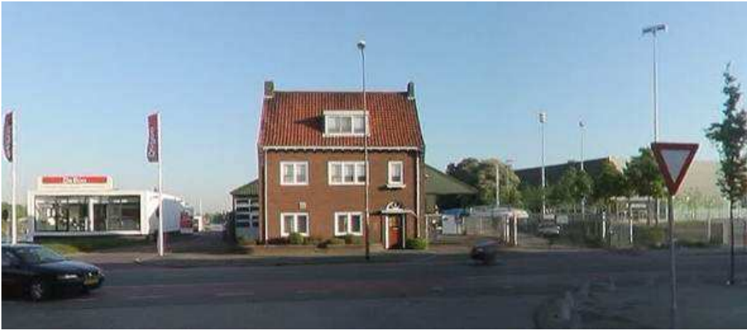
Zicht bebouwing op de kop van de landtong
