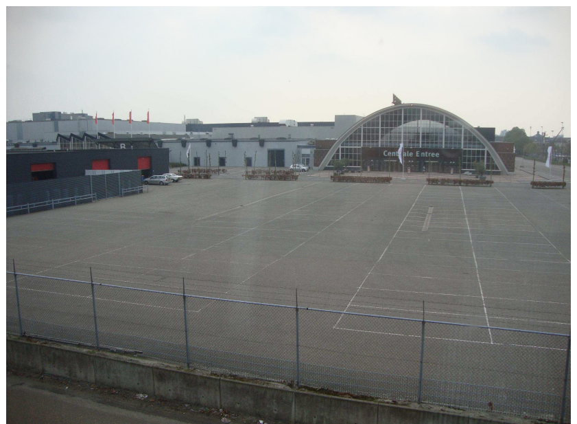
Zicht op parkeerterrein Brabanthallen
