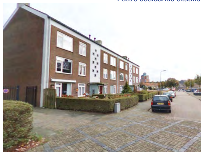
Foto's bestaande situatie
