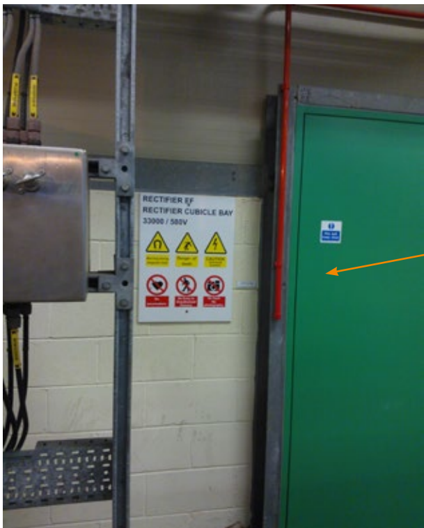
Figuur 3.3 — Beperking van de toegang tot een gelijkrichter celruimte
