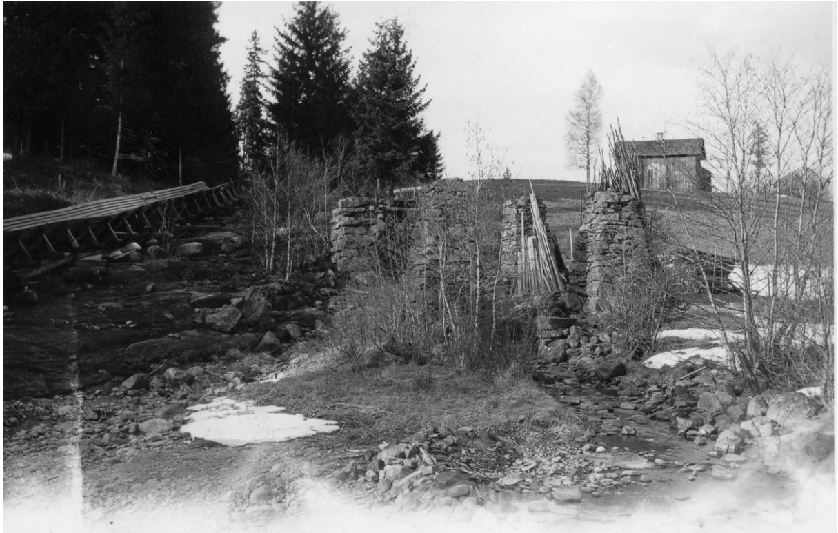
Bilden visar en timmerränna. Vattendraget dämdes upp och timret leddes genom timmerrännan.
