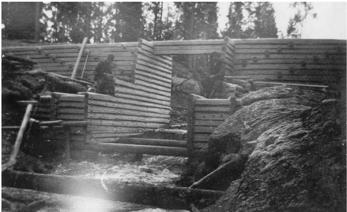
Dambyggnation vid utloppet från Lisslevattnet till Lisslevattsbäcken 1940. Dammen stod kvar länge men revs ut i början av 2000-talet. Vissa rester från flottningsepoken finns kvar, men annars är alla vandringshinder borttagna mellan Töck och Lisslevattnet. Dock återstår problemen med rensningarna av stor sten och brist på lekomyråden
