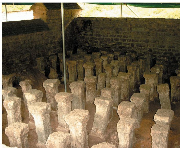
Dagligstue med varmeanlæg (hypocaustum) (rum nr. 26). Det antikke gulv er styrtet sammen. De mange små søjler, der bar det antikke gulv, kan ses.
