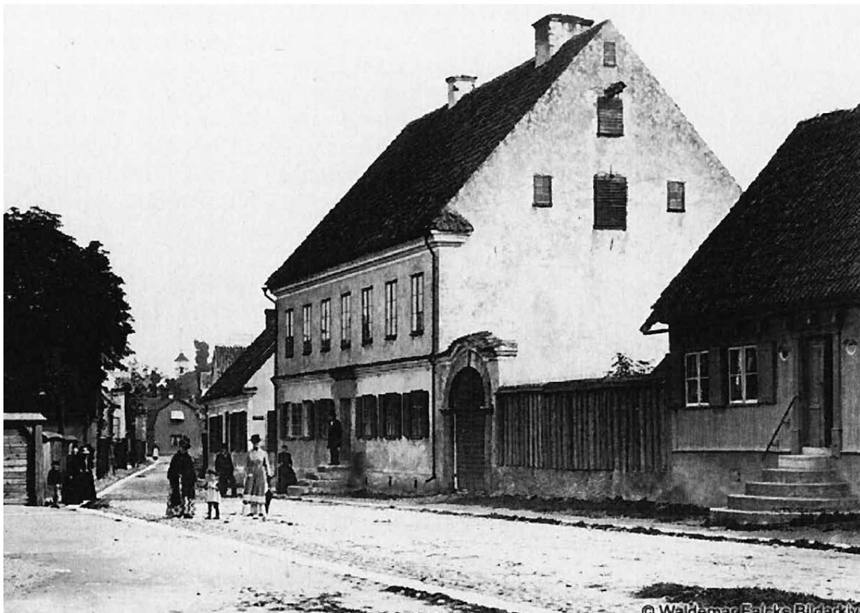
Fastigheten på Kinbergs plats nr 8 inköptes 1892. På trappan till fastigheten står Konsul J.N Kinberg
