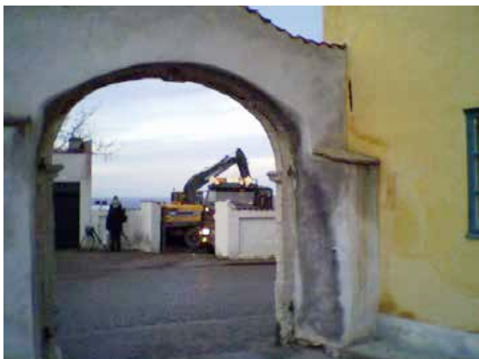
Rivning av granntomten inför byggandet av nytt 3-våningshus, 2006
