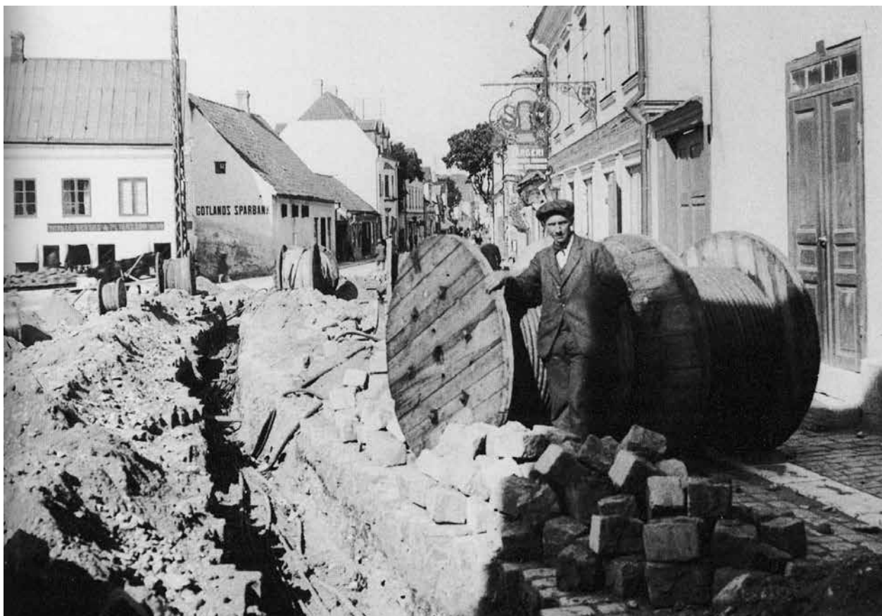
Kabeldragning på Södertorg tidigt 1900-tal.
