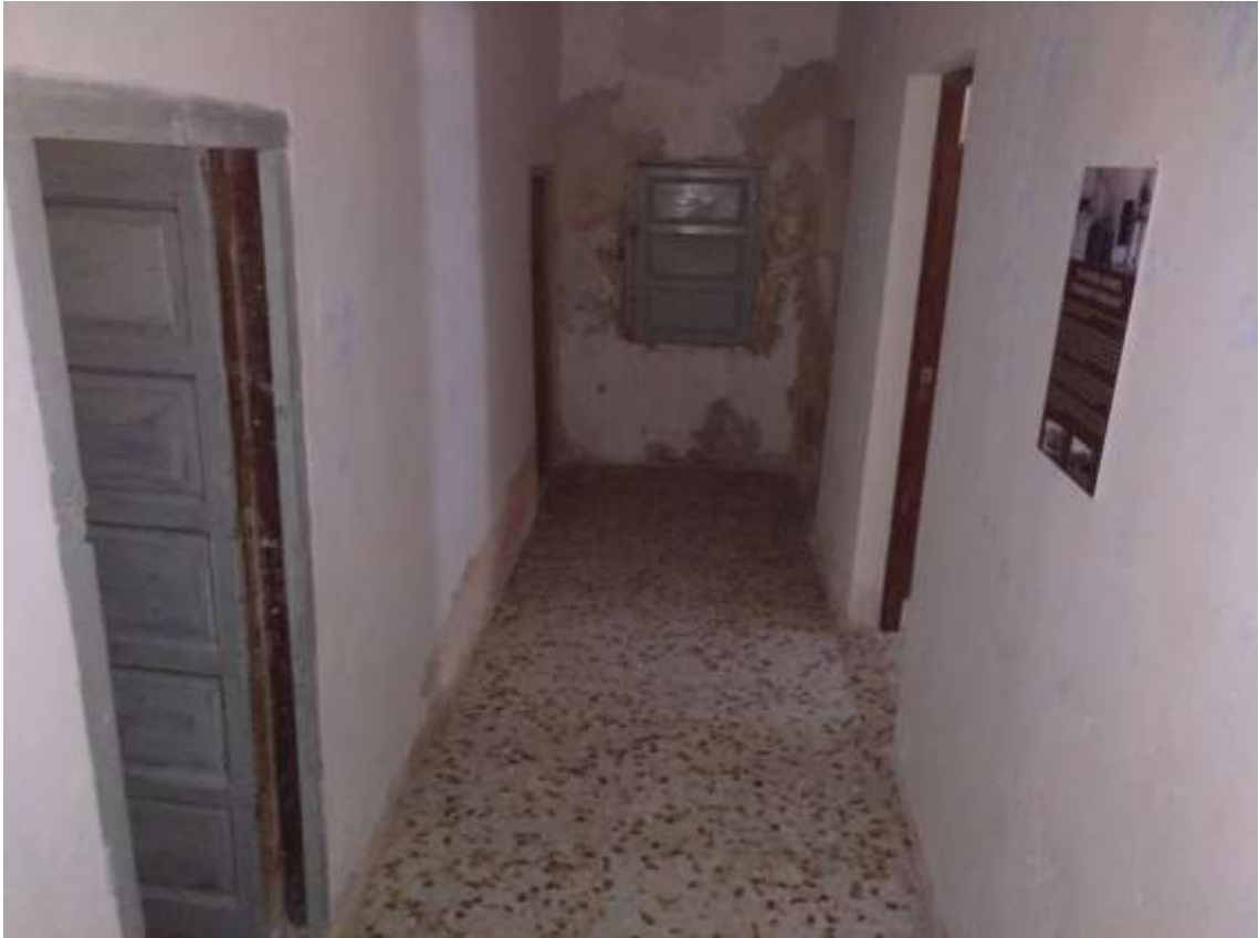
Vista del pasillo de la Casa del Santero en su planta baja.
