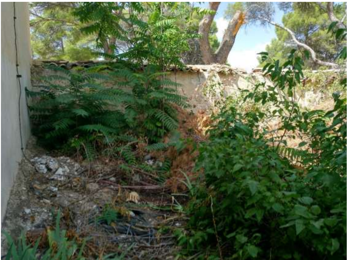
Vista del interior del patio 2.
