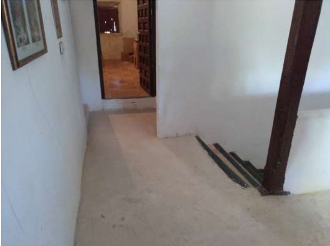
Vista del distribuidor de la Casa del Santero en su planta primera.
