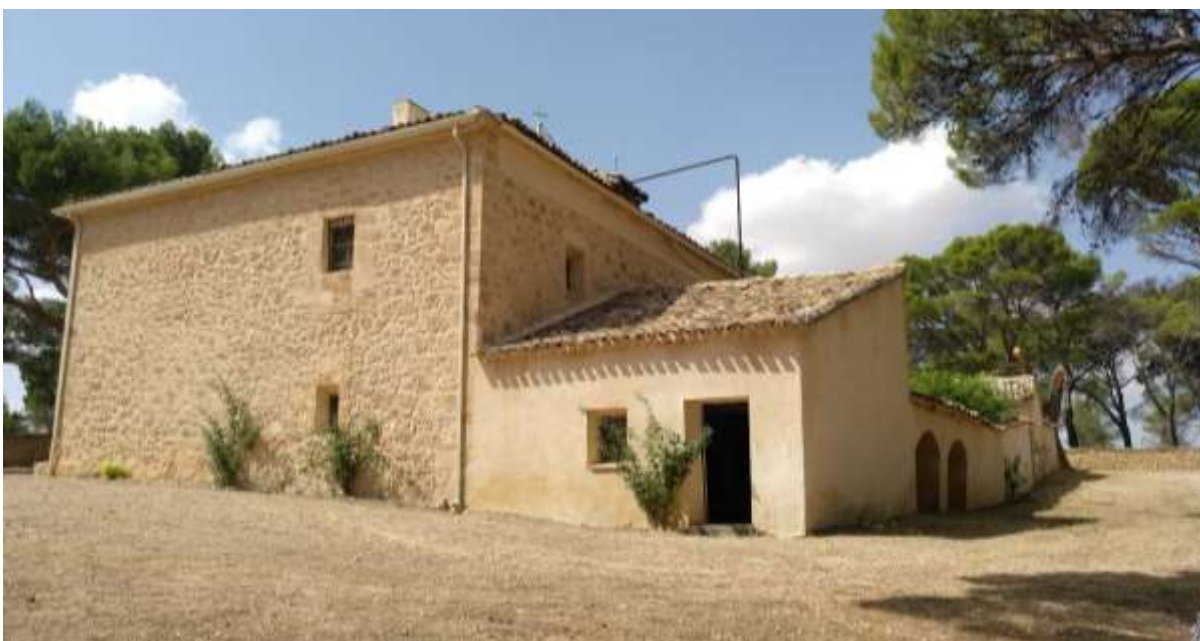
Vista exterior de la Casa del Santero. Alzado noreste. Diferenciación del volumen de dos plantas que constituye la casa del santero, del resto de construcciones que son la sala del aljibe, el aljibe y las cuadras (de menor entidad constructiva).
