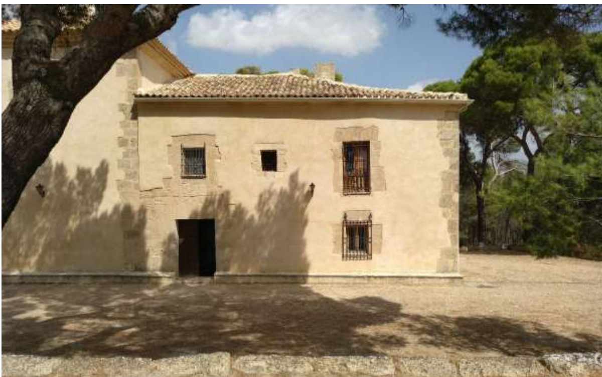
Vista del acceso a la Casa del Santero. Alzado sureste.
