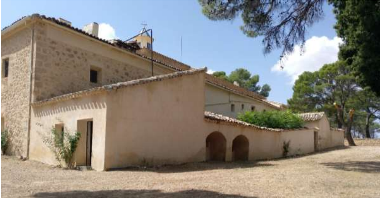
Vista del alzado norte. De izquierda a derecha encontramos: la sala del aljibe, los bebederos y el aljibe, cuadra 1, patio 1, cuadra 2 y patio 2.
