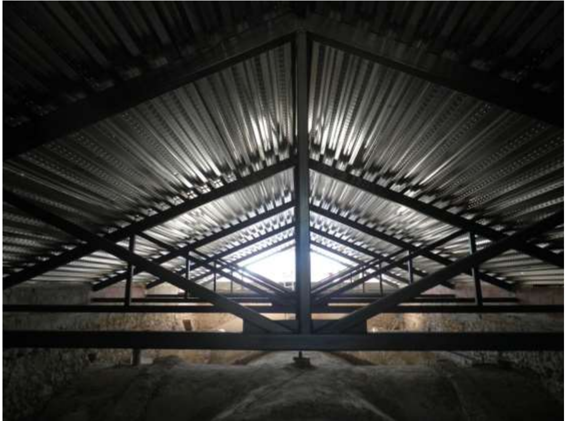
Fotografía de estado reformado
