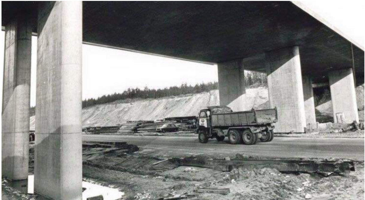
- |Aanleg viaduct E8, 1971
