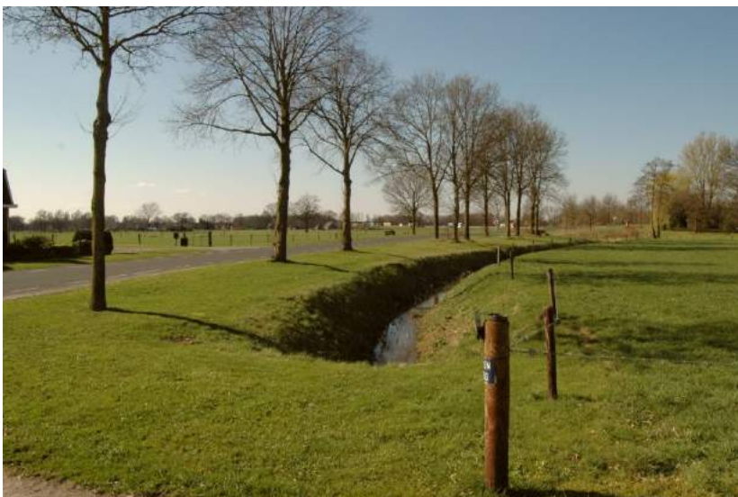
Stokreefsweg, de oprit naar het viaduct
