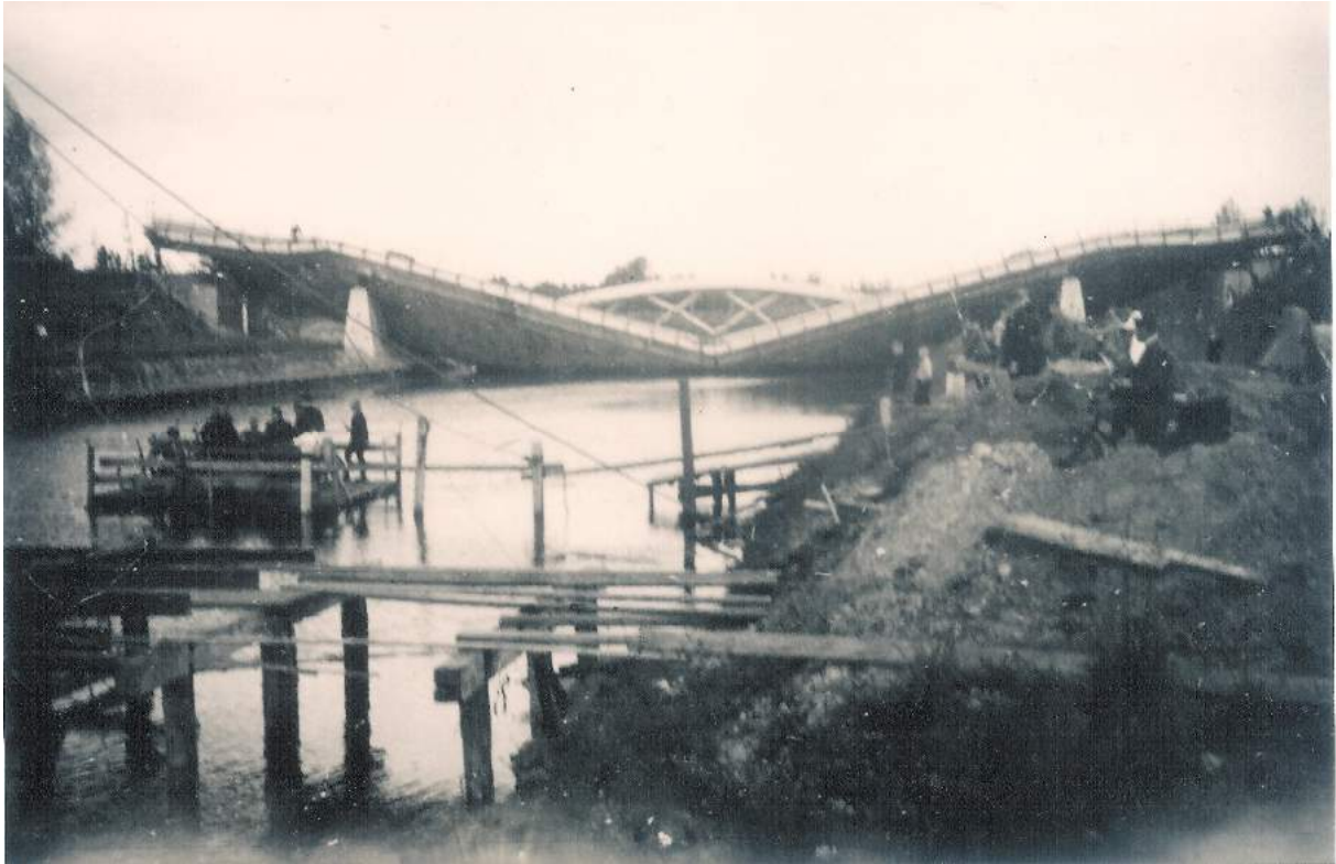
Hoesselderbrug is opgeblazen; met een trekveer naar de overkant.
