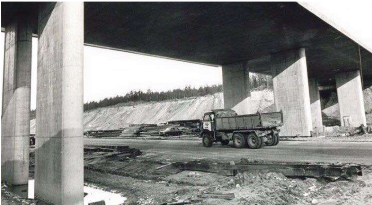
- |Aanleg viaduct E8, 1971
