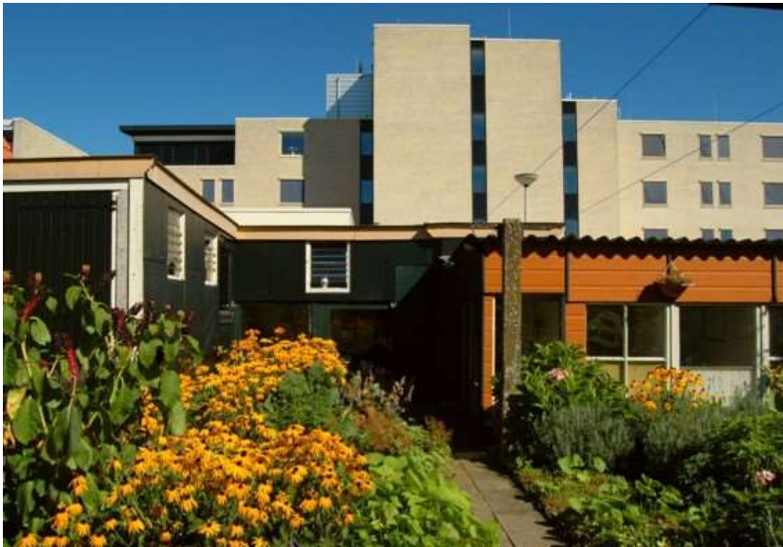
Het Reggedal, gezien vanuit de Julianastraat.
