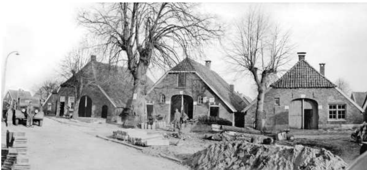
1961, aanleg trottoir op de Hogebrink
