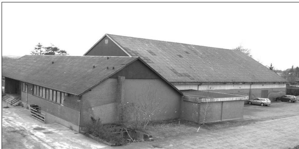
Den gamle skolehal umiddelbart før nedrivning. Den blev 49 år!
