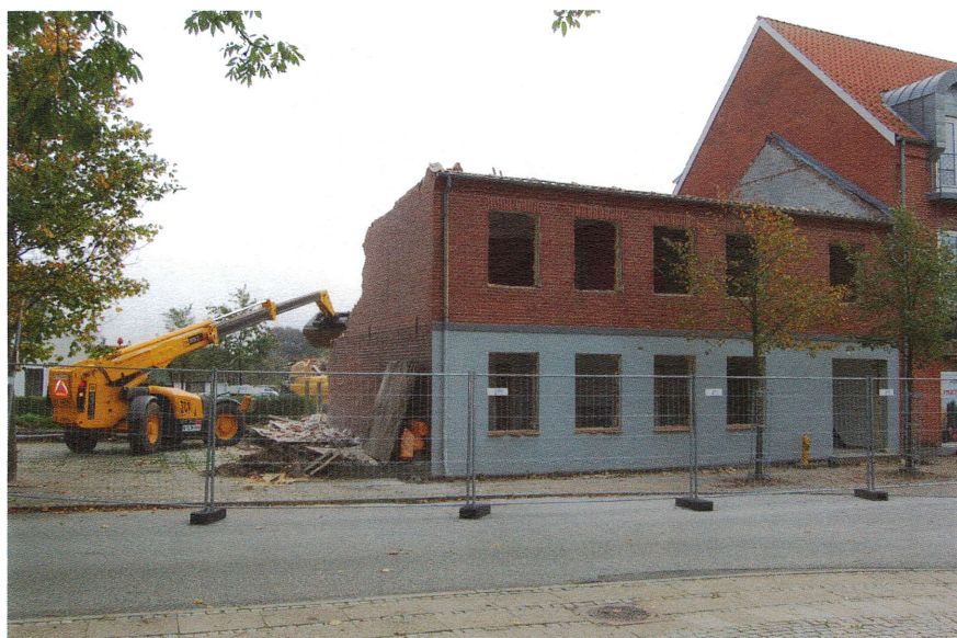
Oktober 2006: Nedrivning af den gamle central( skole før 1908), Bredgade 16
