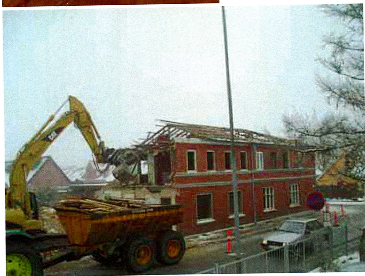
Forår 2006. Bredgade 23 nedrives for at give plads til "Højhuset".
