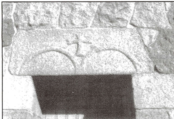
Over udvendig dør på korets sydside ligger tympanon nr. 4.
