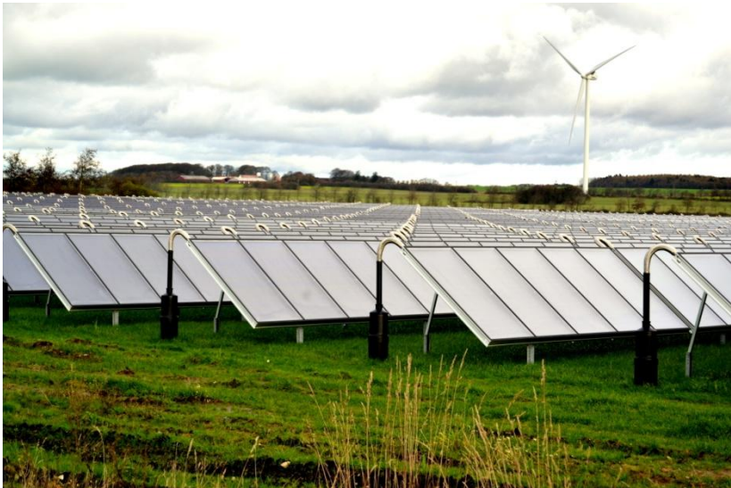
Solfangeranlæg ved Romvigvej
