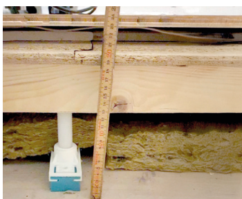
M2. KL-Trä, Ljudfot 25 mm med 150 mm plastskruv, golvspån 22 mm, 1 x golvgips, Aerolen, parkett.
