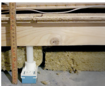
M5/M19. Referensbjälklag betong, Ljudfot 25 mm med 150 mm plastskruv, golvspån 22 mm, 1 x golvgips, Aerolen, parkett.
