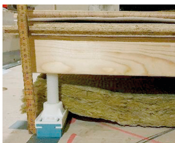
M1. KL-Trä, Ljudfot 25 mm med 150 mm plastskruv, golvspån 22 mm, Aerolen, parkett.
