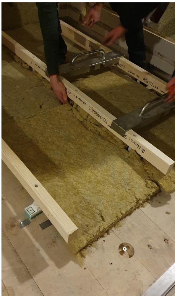
Figur B4.3: Montering av regler, prov M1.
