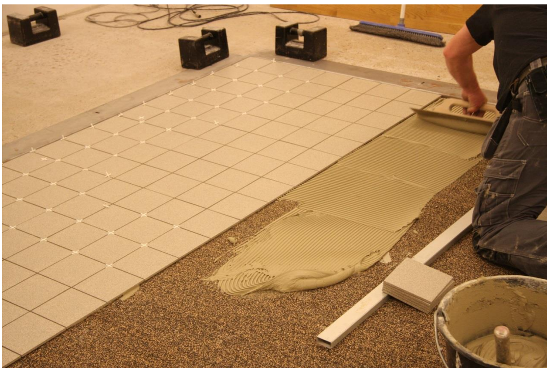
Bild 2 – Läggningsen av klinker.
