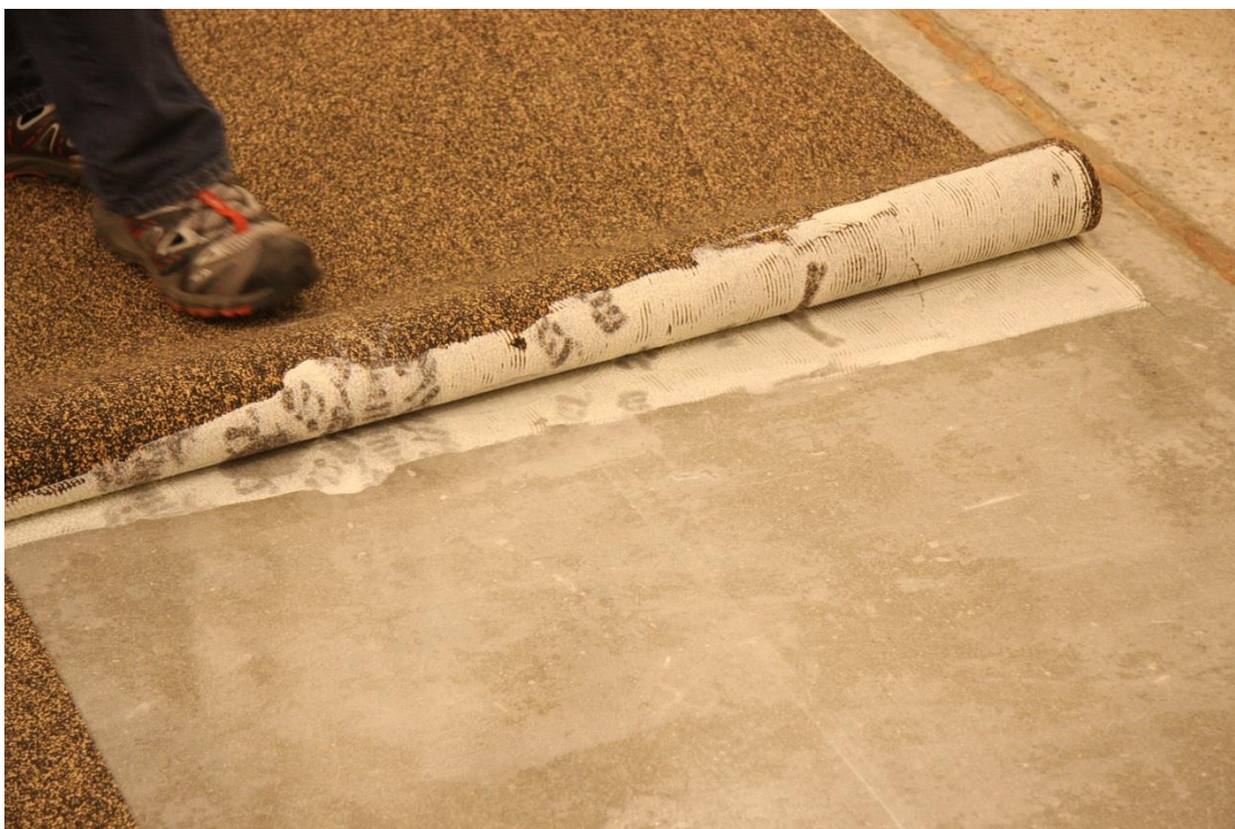
Bild 1 – Limningen av underlägget.
