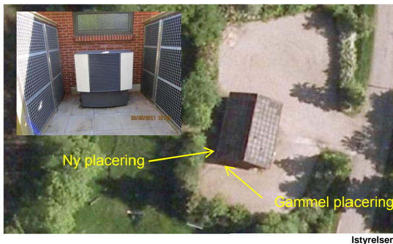
Figur 11.1.2 Flyttet og støjskærmet varmepumpe
