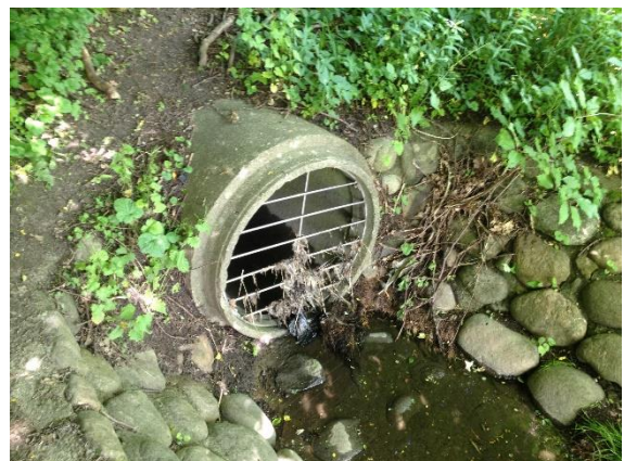
Figur 2 Udløb fra regnvandskloakken
