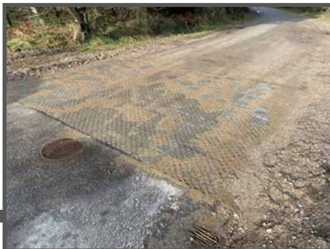
Nye belægningssten ved indkørslen til Værmelandsvej
