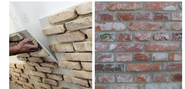
Eksempel på facademoduler af genbrugsteglskaller opsat på plader og fuget
