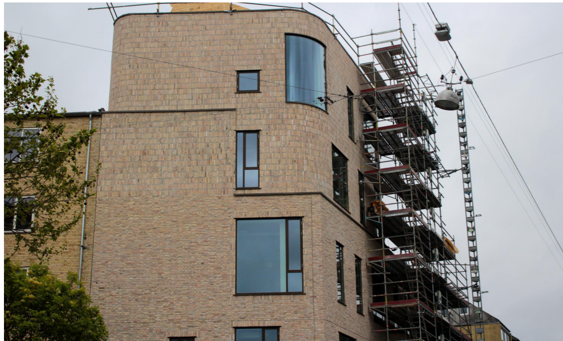
KLUB TEMPELTRÆET (DEL AF SKOLEN VED BÜLOWSVEJ) OPFØRT 2020 ADRESSE: FUGLEVANGSVEJ 8, 1962 FREDERIKSBERG
