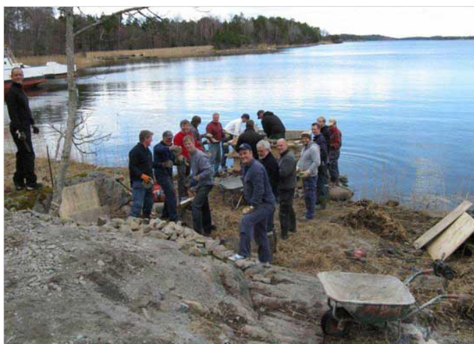
Gångvägen och bryggfundament kräver sin arbetskraft.
