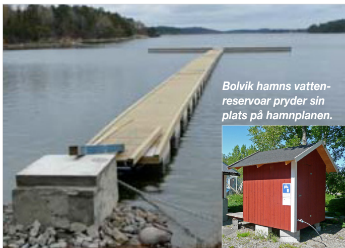
Bryggfundament och brygga. Y-bommar återstår.
