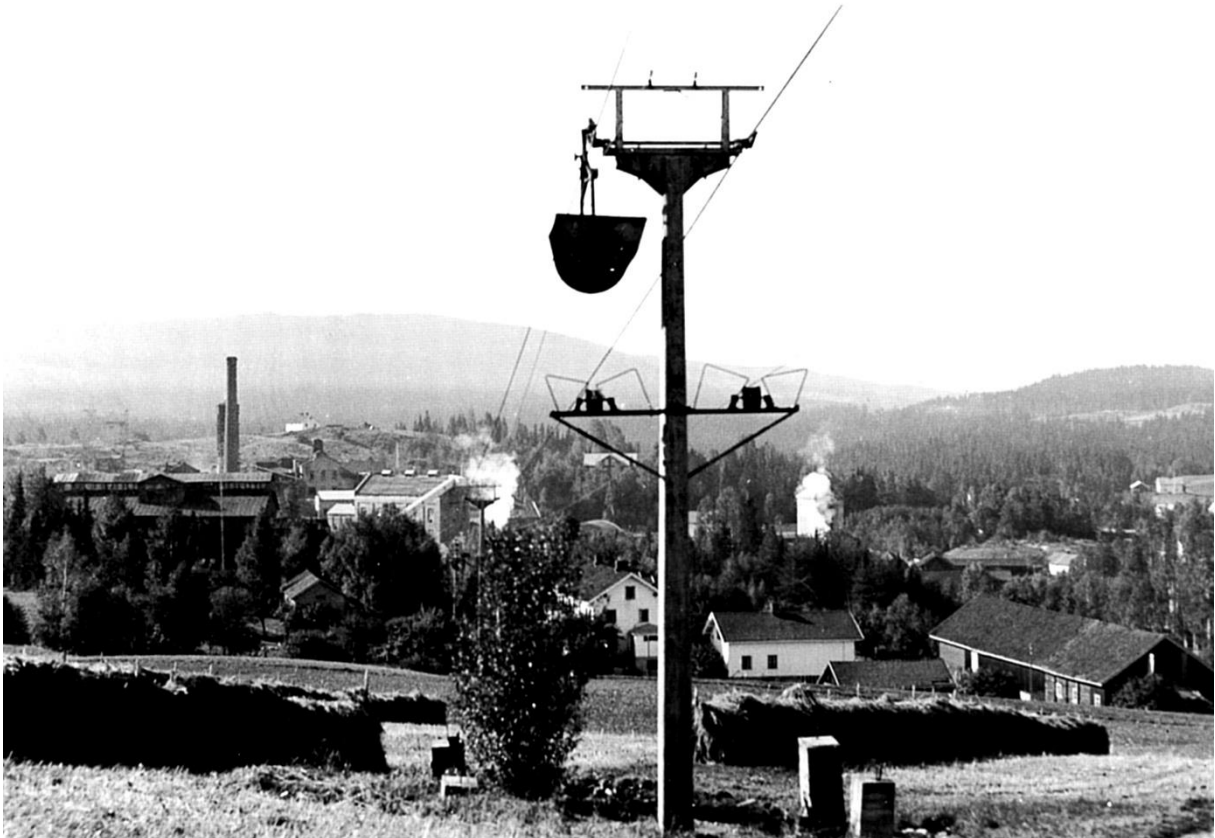
Mast på jordet til Nedre Nygaard. Husene på garden ligger rett nedenfor. Betongmasten har erstattet en konstruert i tre. De fire gamle fundamentene ses rundt masten. Bilde: N. W. Knutsen
