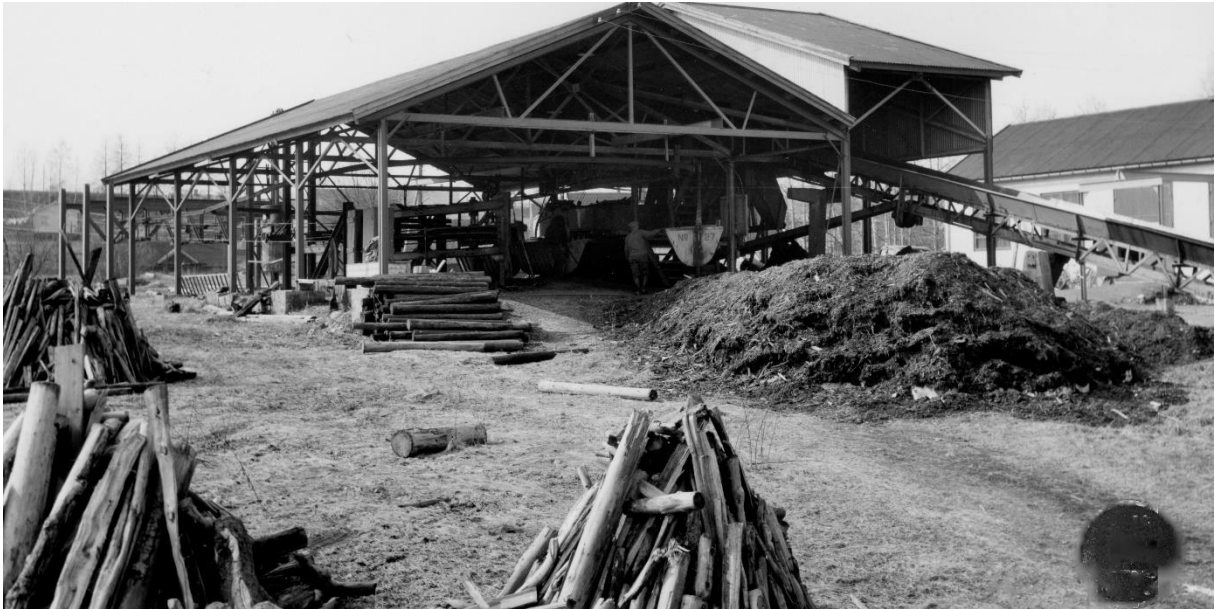
Vendestasjonen sett fra mjøssiden. Transportøren som mater vaggene med kubb fra renseriet til høyre. Bilde: N. W. Knutsen
