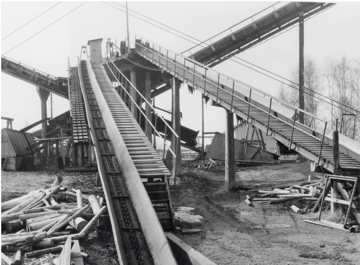
Kubben gikk fra rensetromlene på to transportører inn på en fordelingssentral. Denne kunne fordele kubb til hver av sidetransportørene eller direkte til en ny transportør som fylte vaggene i vendestasjonen. Bilde: N. W. Knutsen
