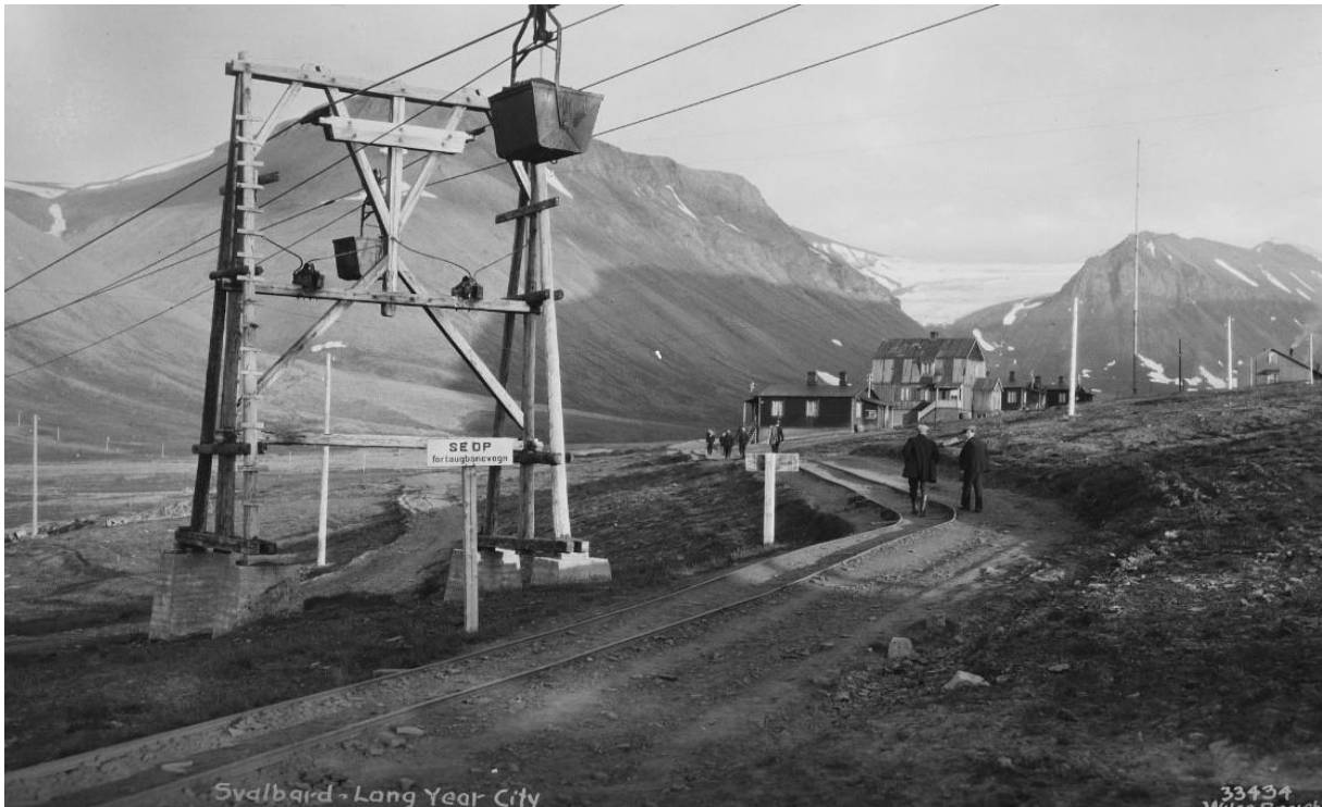
Bildet er fra Longyearbyen på Svalbard og viser master og taubane temmelig likt løsningen som Toten Cellulosefabrikk benyttet opprinnelig. Bilde: Wilse
