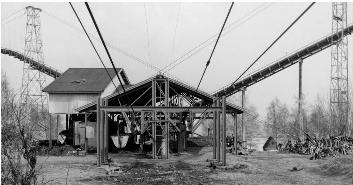
Vendestasjonen sett fra vest. Vagger fylt med kubb kommer ut fra stasjonen til venstre. Bilde N. W. Knutsen
