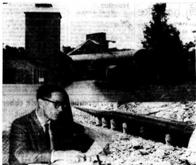
Øverst: Innrykk på fabrikken. Kokeriet med det nye påbygget i midten. Stillasene er reist p. g. a. takreparasjoner. Under litt av den lange turbinledningen som snor seg som en slange oppover Hunnaelvas dalbøe. Innfelt: overingeniør Georg Sverdrup ved arbeidsbordet.
