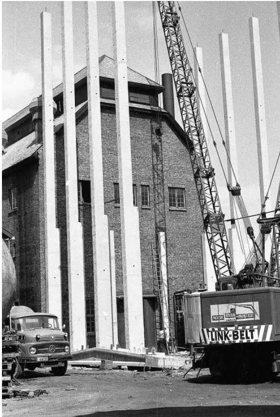
Bygging av ny syklontørke for Totanin i 1971. Gjorde det mulig å produsere nye kvaliteter til bruk i oljeindustrien
