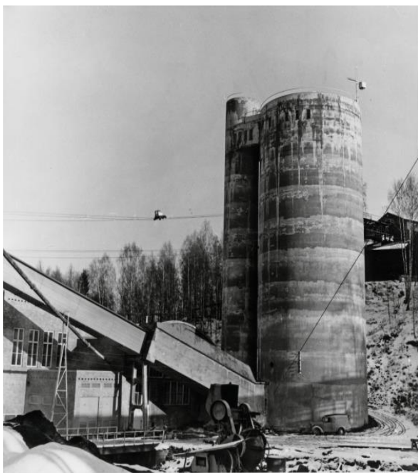
Flissilo ble bygget i 1953. Første og største i Norge. Ble støpt med glideforskaling på 10 dager. 38 meter høy.
