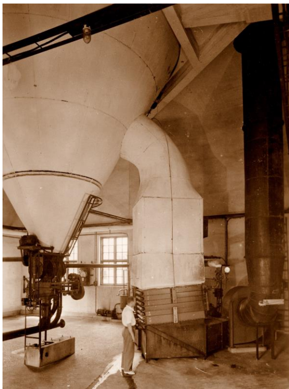
Til venstre ser vi bunnen av en av tørkesyklonene i NIRO med vifta som blåste inn varm luft. Til høyre inspiserer Karl Ander det ferdige Totanin-pulveret før det går til pakking.
