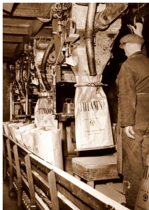
Ole Ellingsen jobbet i pakkeriet for Totanin i mange år. Her fra tidlig på 60 tallet. Pakkeprosessen ble modernisert en rekke ganger, og på 70 tallet var det automatiske vekter som fylte sekken. Operatøren lukket sekken og slapp den ned på transportbåndet som gikk til lageret.
