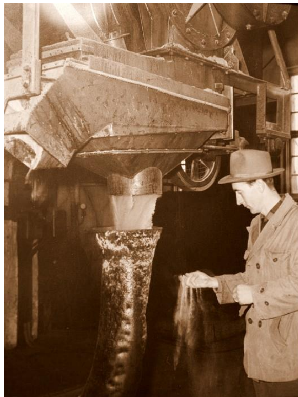
Til venstre ser vi bunnen av en av tørkesyklonene i NIRO med vifta som blåste inn varm luft. Til høyre inspiserer Karl Ander det ferdige Totanin-pulveret før det går til pakking.
