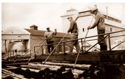
Tømmeret ble lagt i en kum hvor det ble ordnet før en transportør tok det inn i renseriet for kapping, barking og opphogging til flis.
