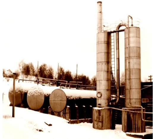
Syretårnene hvor svovelgassen ble løst opp i ammoniakk for å lage kokesyre. Noen ganger ble det mer gass enn det som kunne løses opp og da gikk gassen ut i lufta. Området rundt her ble kalt syrehaugen og var helt goldt og uten grønne vekster.
