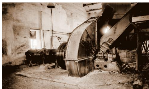
Etter barking ble tømmeret sendt ned i renna og hugget til flis av denne huggeren. Drevet av en elektrisk motor på 250 hester og laget et ubeskrivelig bråk. Bilde er fra før moderniseringen på 1950-tallet.
