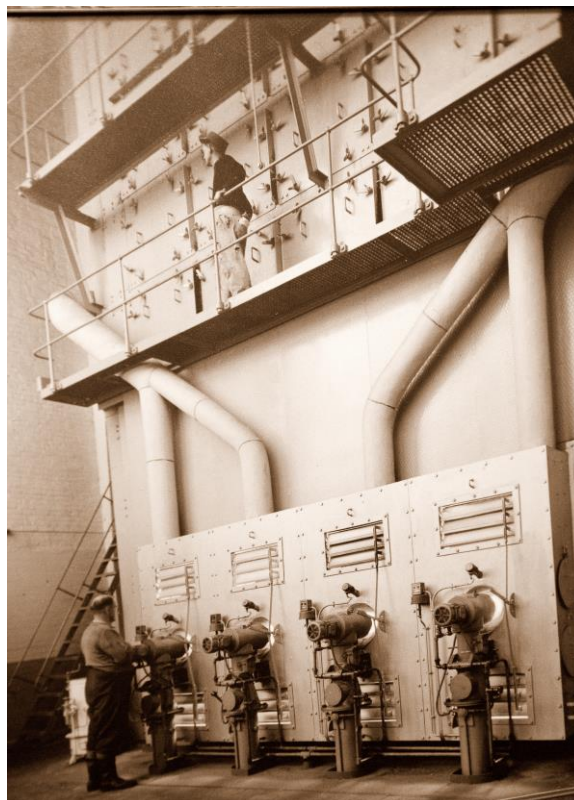
Danskekjelen. Det var ei voldsom ildmørje inni kjelen med fire store oljebrennere som sprutet inn varme. Over brennerne var kjelen fylt med rør hvor kaldtvann ble til damp under stort trykk.
