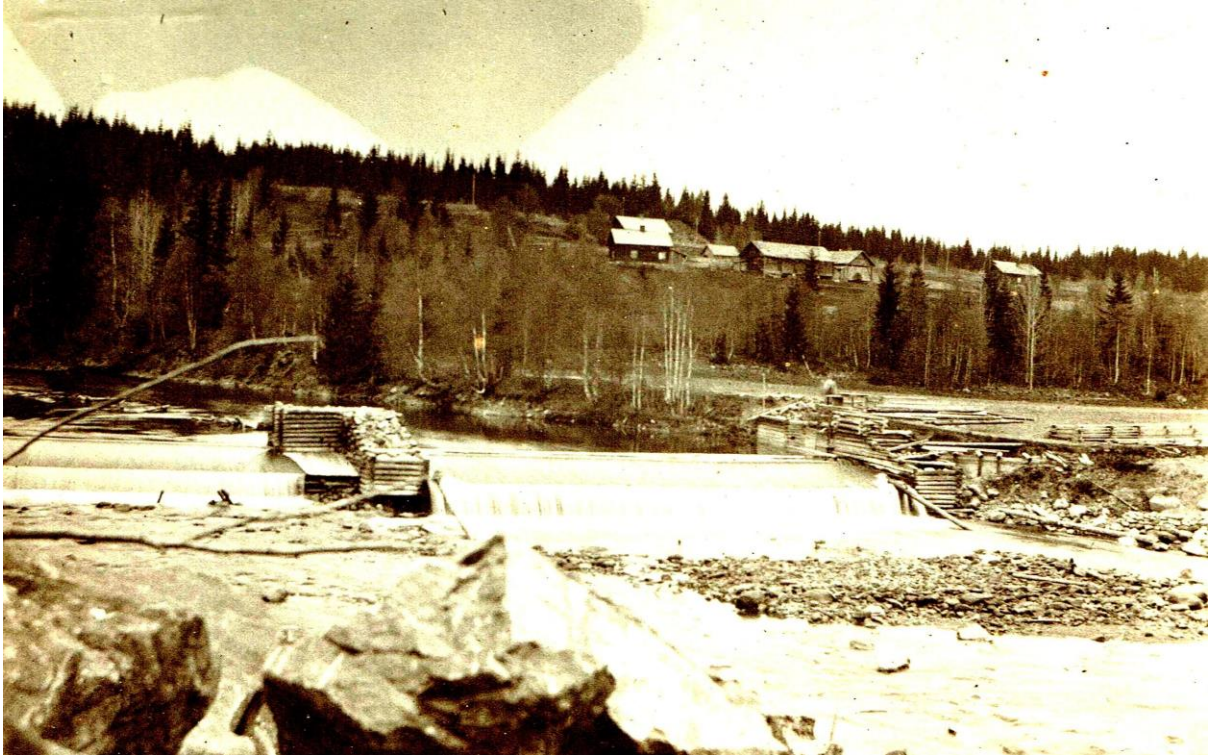
Den gamle laftedammen ved Rud som ble erstattet av ny i andre enden av Beritknappen.
