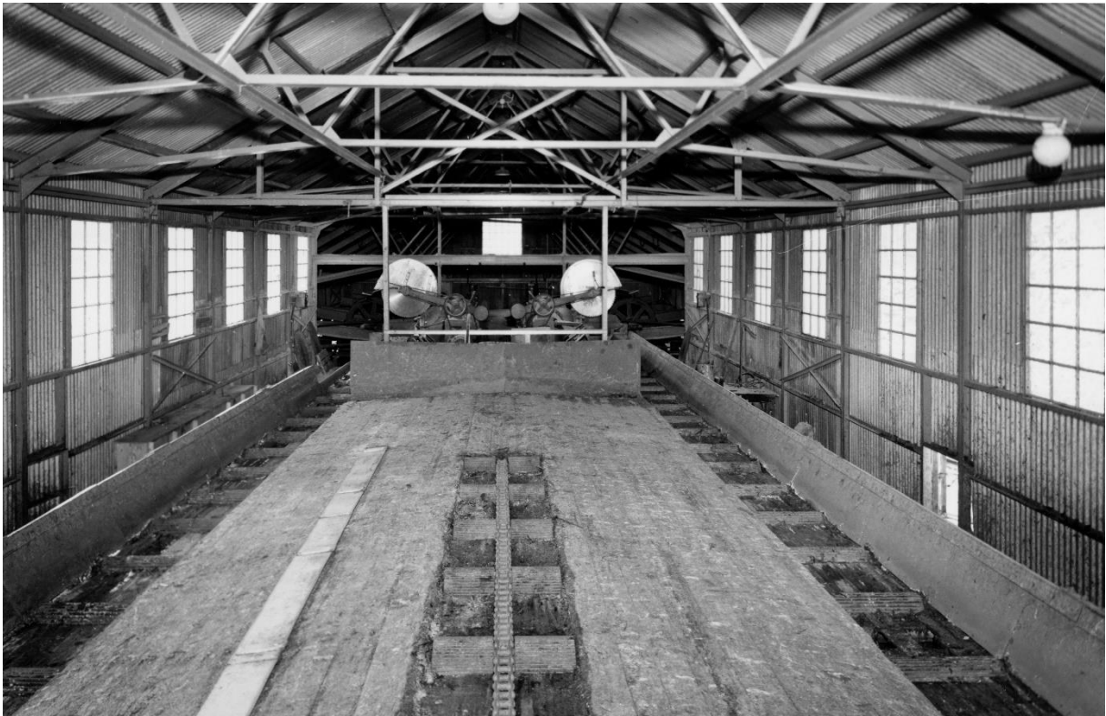
Kappeanlegget. Transportøren fra kjerraten i midten. Stokkene ble veltet til side inn på linjene til kappsagene i bakgrunnen. Tømmeret ble kappet til kubbe som falt med på transportører som tok det videre til fordelinbgssentralen. Bilde: N. W. Knutsen
