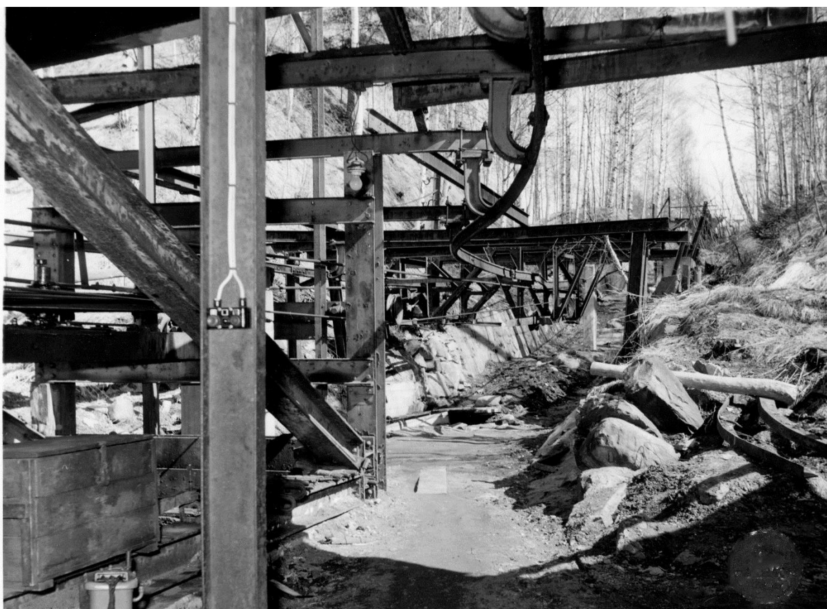
Fra vendestasjonen. Legg merke til skinnen for retur av vagger. Bilde: N. W. Knutsen
