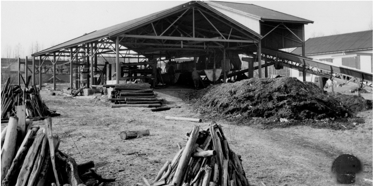
Vendestasjonen sett fra mjøssiden. Transportøren som mater vaggene med kubbe fra renseriet til høyre. Bilde: N. W. Knutsen
