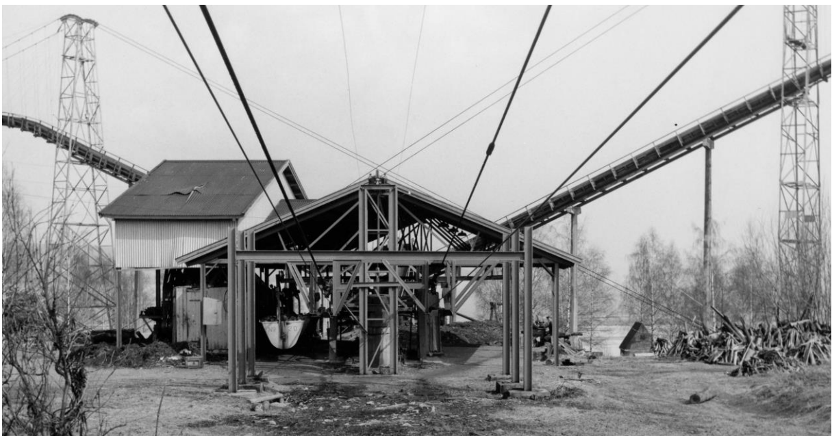
Vendestasjonen sett fra vest. Vagger fylt med kubbe kommer ut fra stasjonen til venstre. Bilde N. W. Knutsen
