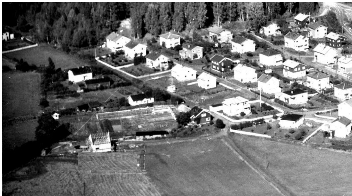
Postkort fra 1952 viser gartneriet til Sigmund Granvin. Foran er Stian Rabe i gang med å bygge sin enebolig. Gartneriet lå på Nedre Gjøviks grunn mens Rabes tomt lå på grunn fra Øvre Gjøvik.
