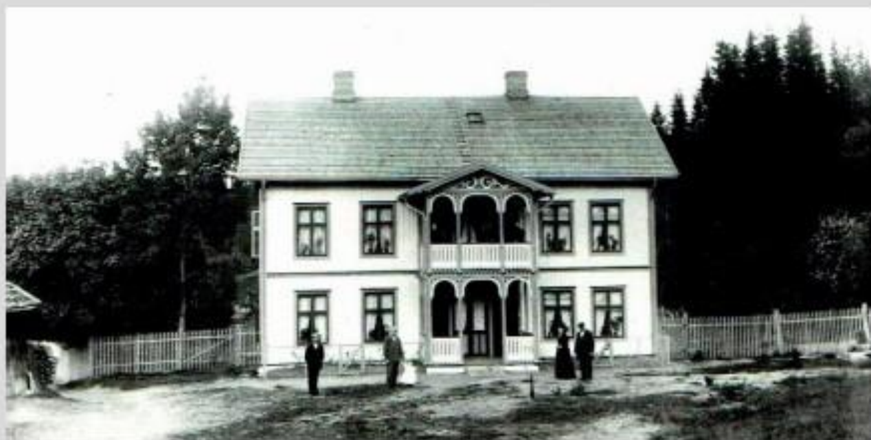
Da Inge Andrea og Børre med barna flyttet til Engen i Hunndalen i 1868 hadde bolighuset bare en etasje. Børre døpte stedet om til Lilleengen. I 1896 ble huset påbygget og fikk en etter tiden fasjonabel fasade i sveitserstil. Her bodde Inge Andrea og Børre til de døde i henholdsvis 1907 og 1909. Etter å ha bodd på Glæstad, i Snertingdal og Gjøvik bodde også Johanne og Bernt Lilleengen her fra 1903. Familiekompaniet ble oppløst i 1947 og eiendommene fordelt blant arvingene. Ottar Lilleengen overtok Lilleengen med tomteområde og flyttet inn med familien.
