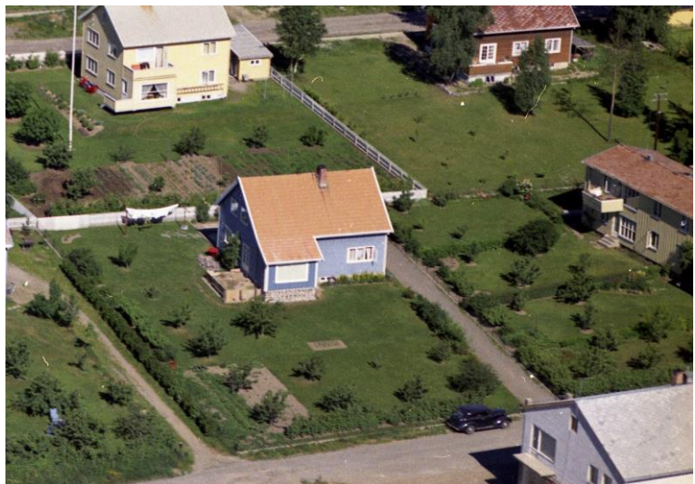
Aage Fodstad og Finn Ditlefsen bygde i Hammerstadsgate 16 firemannsboligen som ses helt til høyre i bildet.
