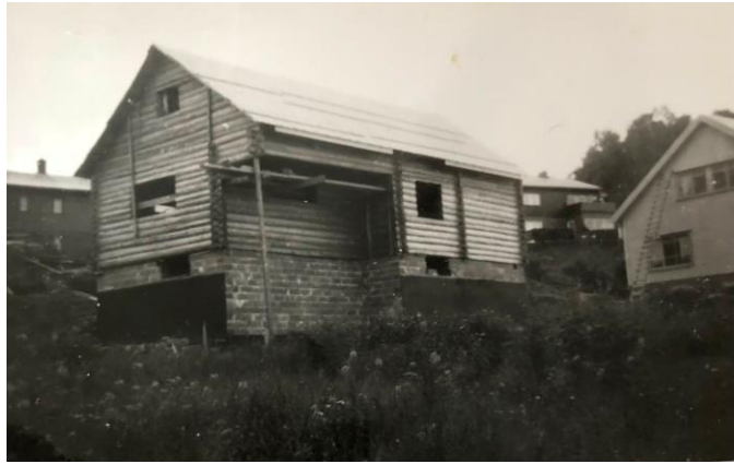
Hytta fra Kvamsfjellet under oppføring i Lundsgate i 1953.
