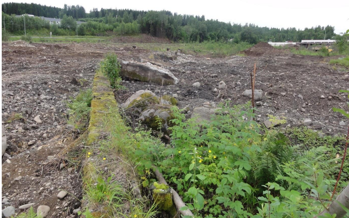
Betongmuren på tomte til COOP som var en del av Damhuggu.
