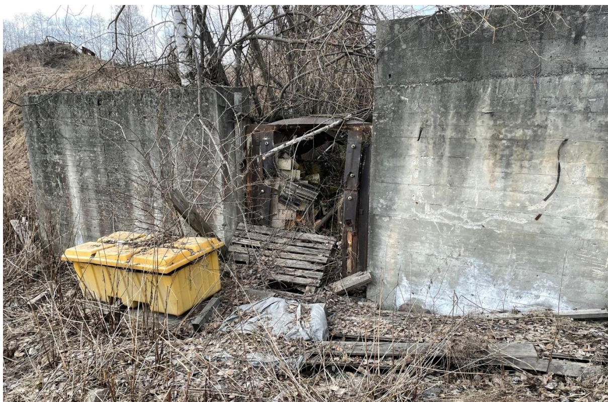
Betongkonstruksjonen for landfestet med utsparingen for luken til kanalen
