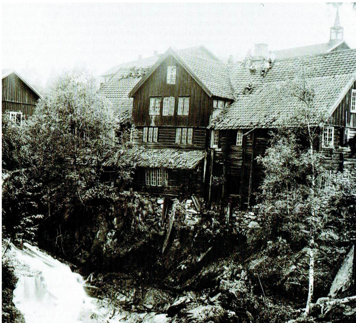
Da Hans Skikkelstad og Ole Hund i 1832 startet Brusveen Staaltraad- og Spigerfabrik bygde de denne bygningen som kalte «hovedanlegget». Den inneholdt spikersaks og trådtrekkeri samt svære vasshjul for driften av disse. Bilde: Mjøsmuseet
