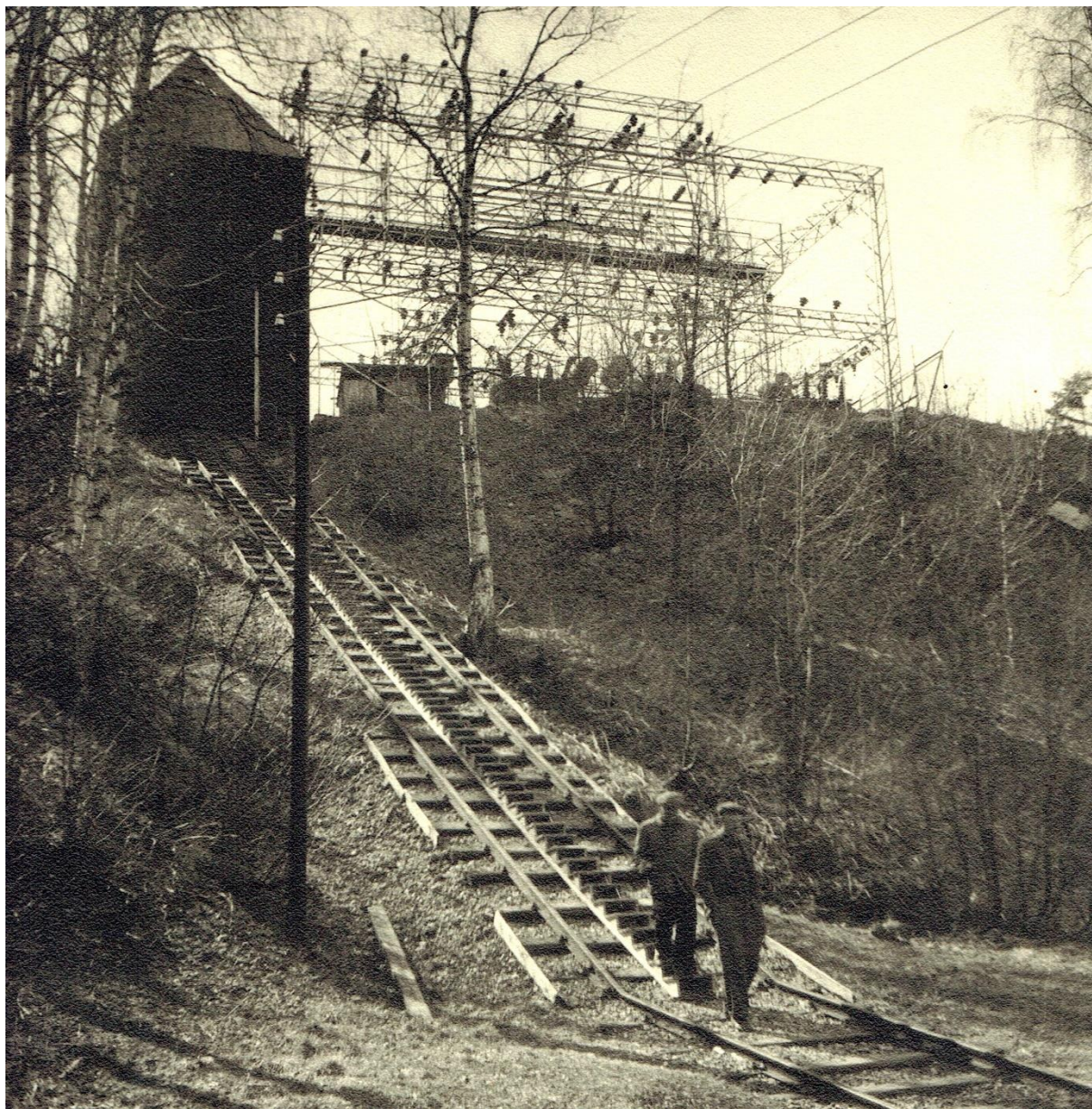
Trafo-anlegget sett fra Brufoss. Skinnegangen ble brukt til å transportere tungt gods som transformatorer til anlegget. Bilde Siri Gunn Simonsen
