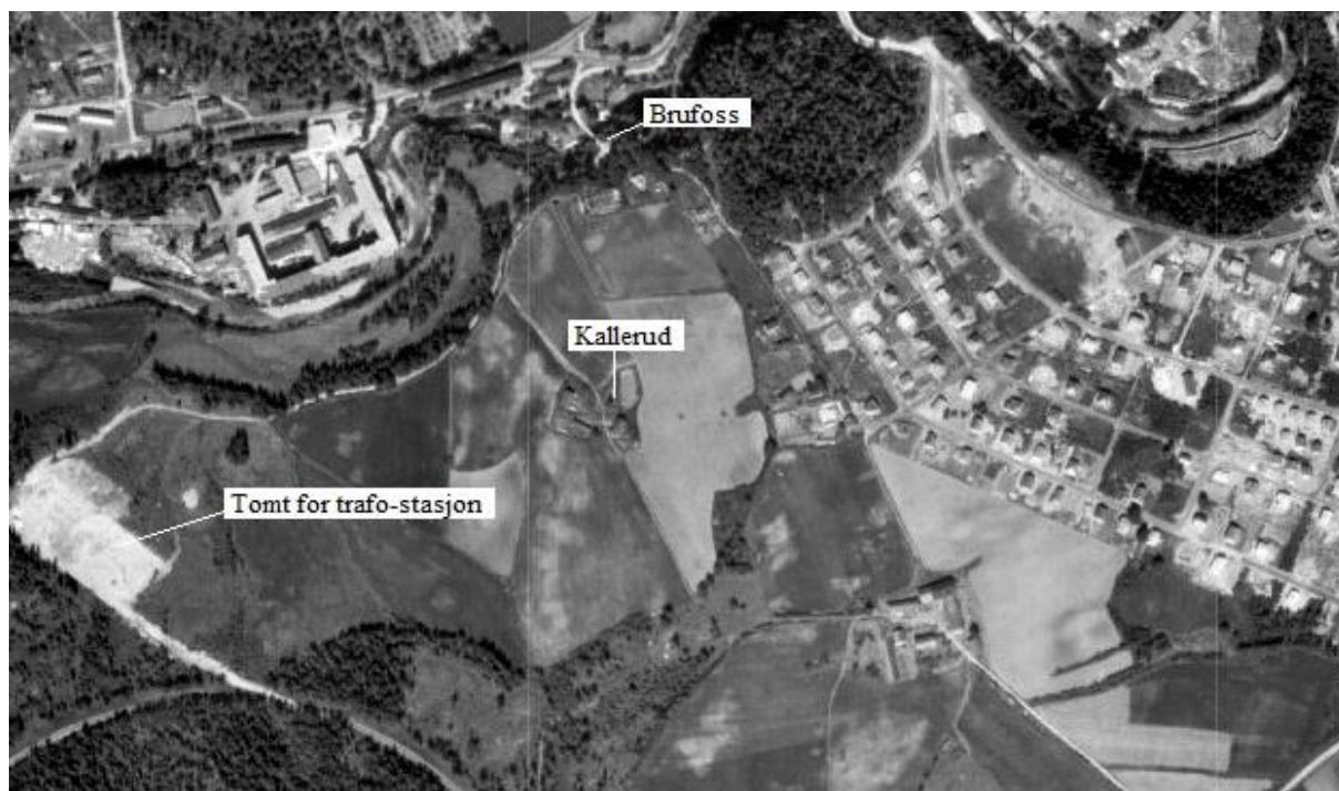
Vertikalfoto fra 1949 viser at tomta for trafo-stasjonen er under planering. Det er også planert for sidespor til jernbenaen hvor det tunge godset ble fraktet inn.
