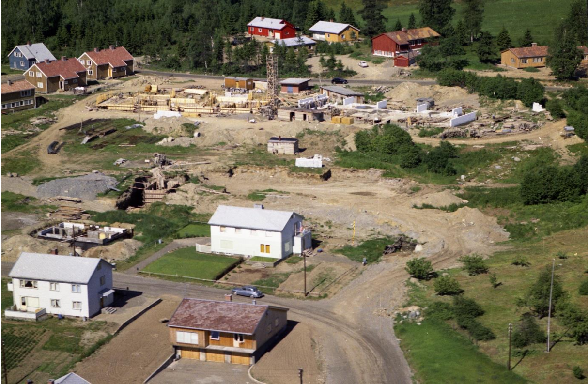
Byggeplassen for Kallerudveien 6/10 1961. Bilde: Widerøe
