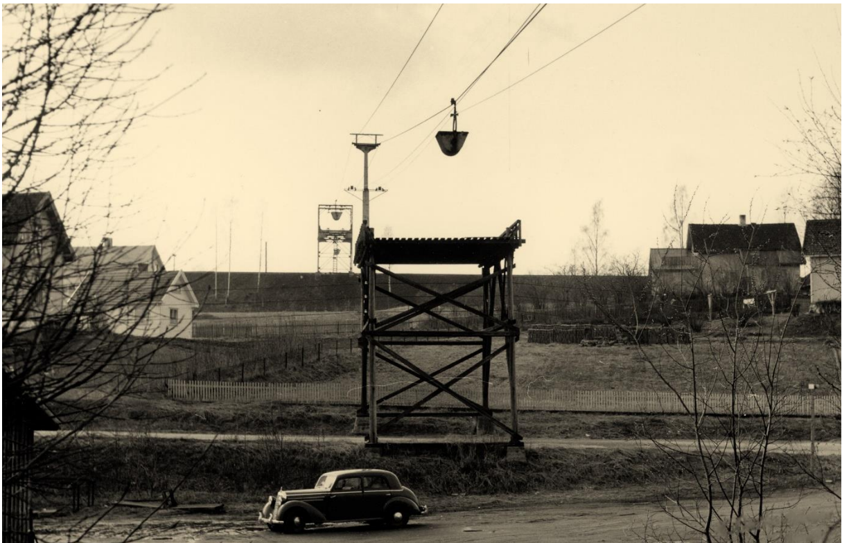
Taubanen på veg vestover fra Rambekkmoen. Under vaggjen ses overbygningen over Østre Totenveg. I bakgrunnen krysser kabelen jernbanen. Der har masten en tilleggsfunksjon som beskyttelse over sporet. Bilde: Mjøsmuséet
