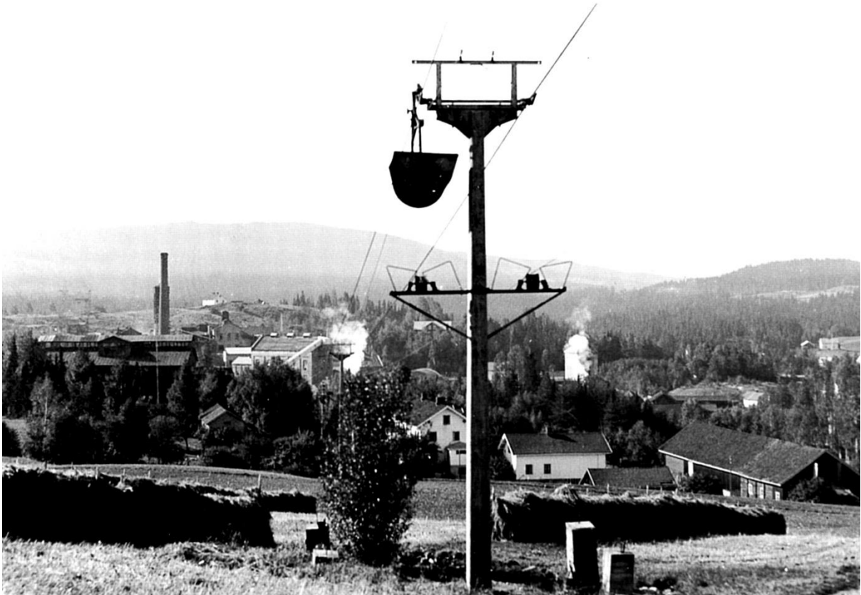
Mast på jordet til Nedre Nygaard. Husene på garden ligger rett nedenfor. Betongmasten har erstattet en tremast. De fire fundamentene ses rundt masten. Bilde: N. W. Knutsen
