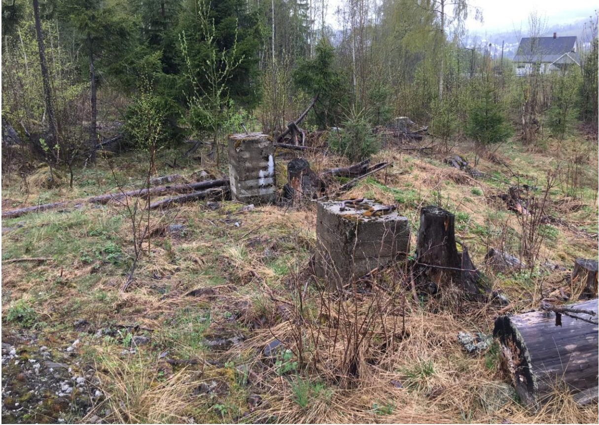
To fundamenter fra en taubanemast i skogen til Topp.
