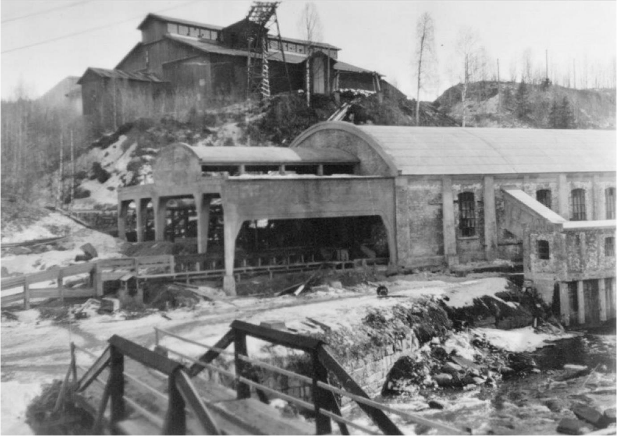
Mottaksstasjonen i Toten Cellulosefabrikk med renseri og flishogger. Bilde: Nasjonalmuséet
