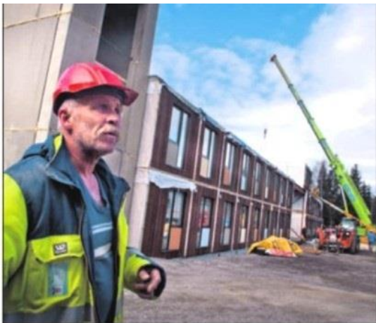
KORTREISTE BYGG: – Hver hybel har eget bad og kjøkkenkrok, forteller byggeleder Jan Olav Ringen ved Moelven ByggModul. Foto: Asbjørn Risbakken
