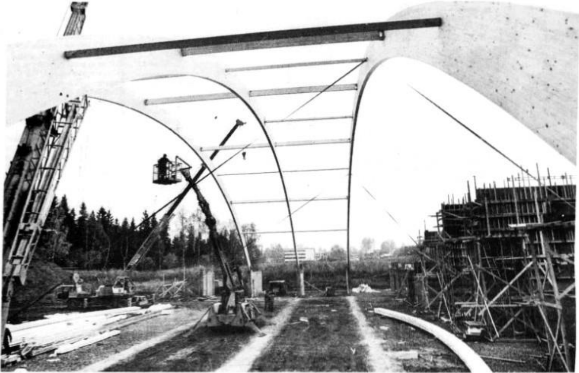
I dag settes den siste av de fem store limtrebuer på plass, og Kallerudhallen i Gjøvik begynner å vise seg mot himmelen. Det er Moelven Brug som har hovedentreprisen.
